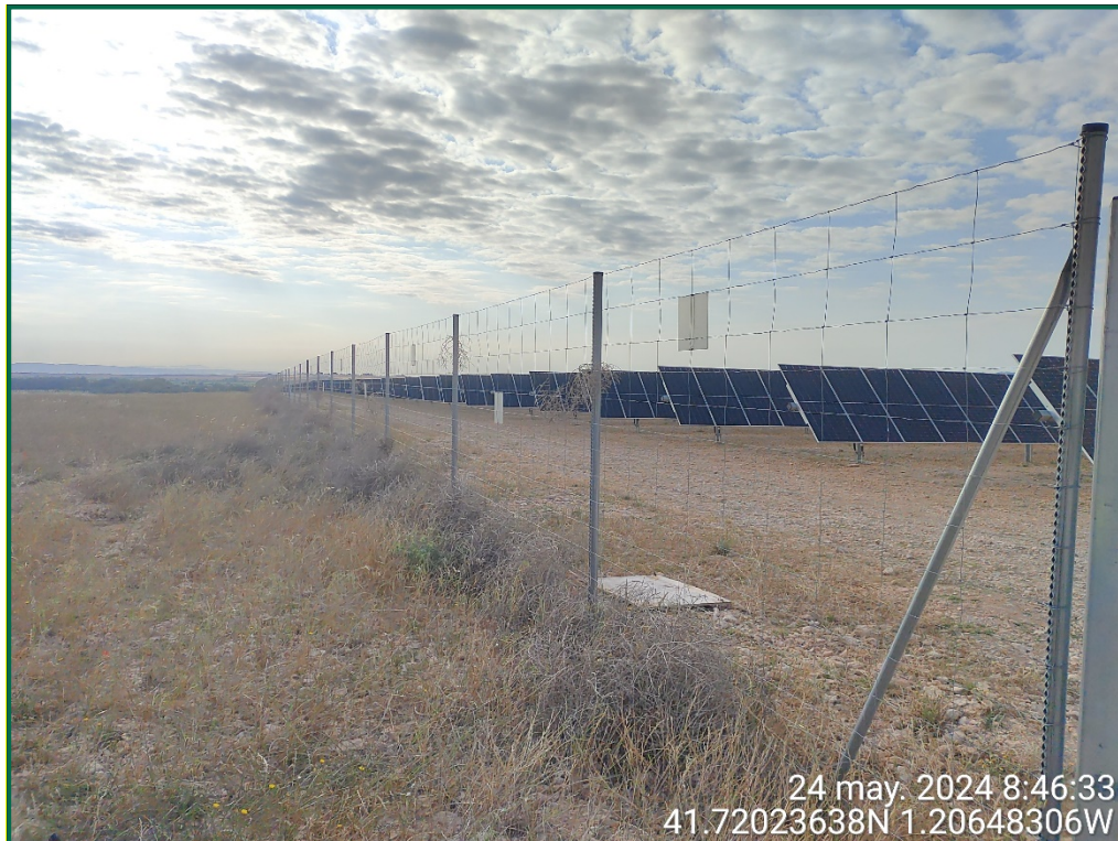
Fotografía 10. Vallado perimetral y placa anticolidión.
