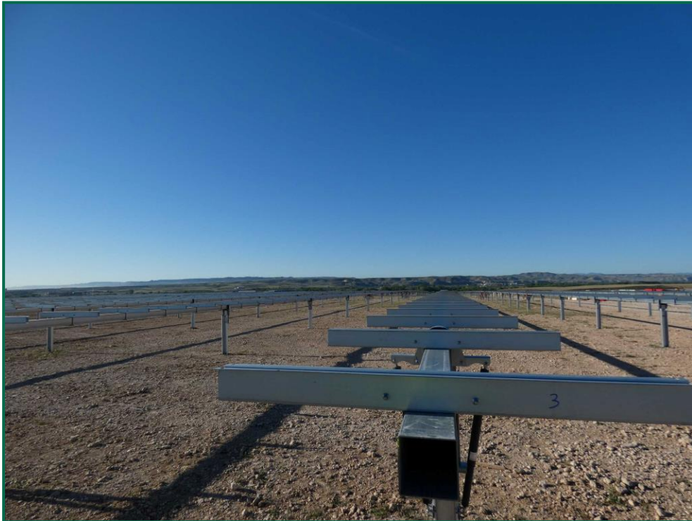
Fotografía 6. Postes verticales y horizontales colocados.
