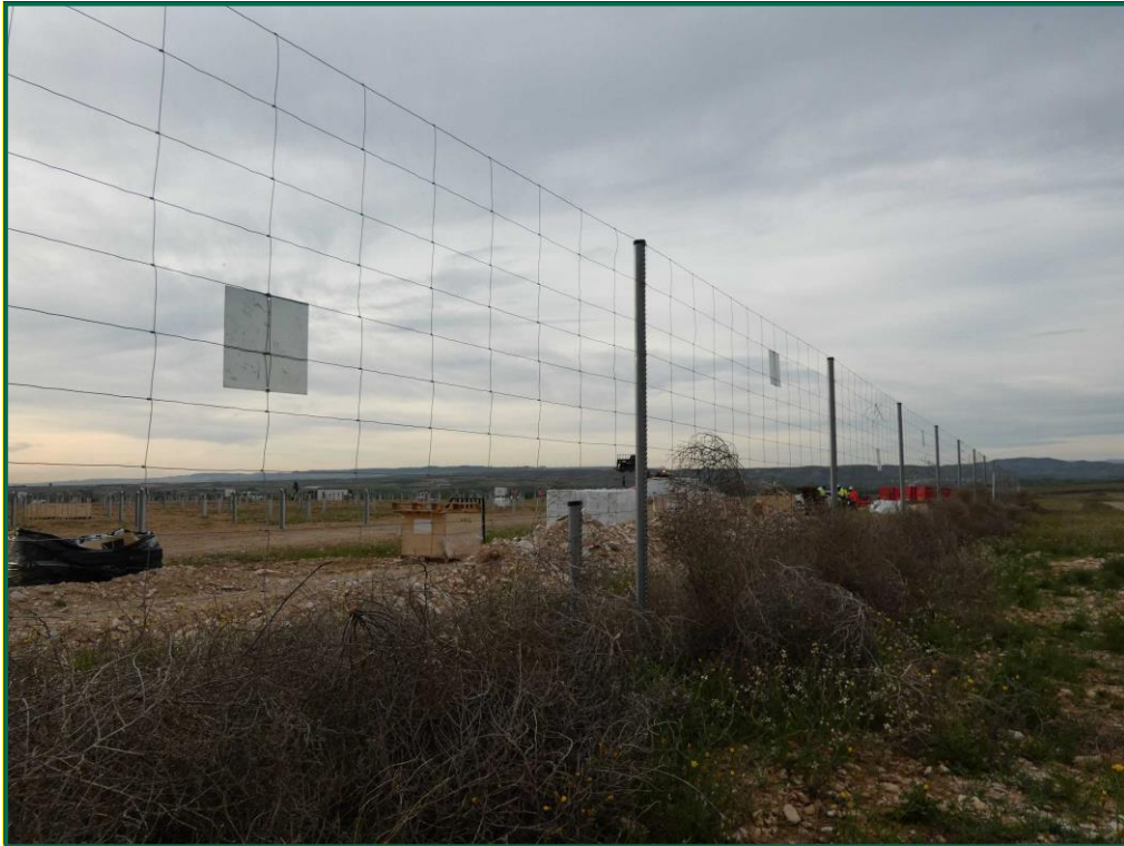
Fotografía 8. Vallado perimetral y placa anticollisión.
