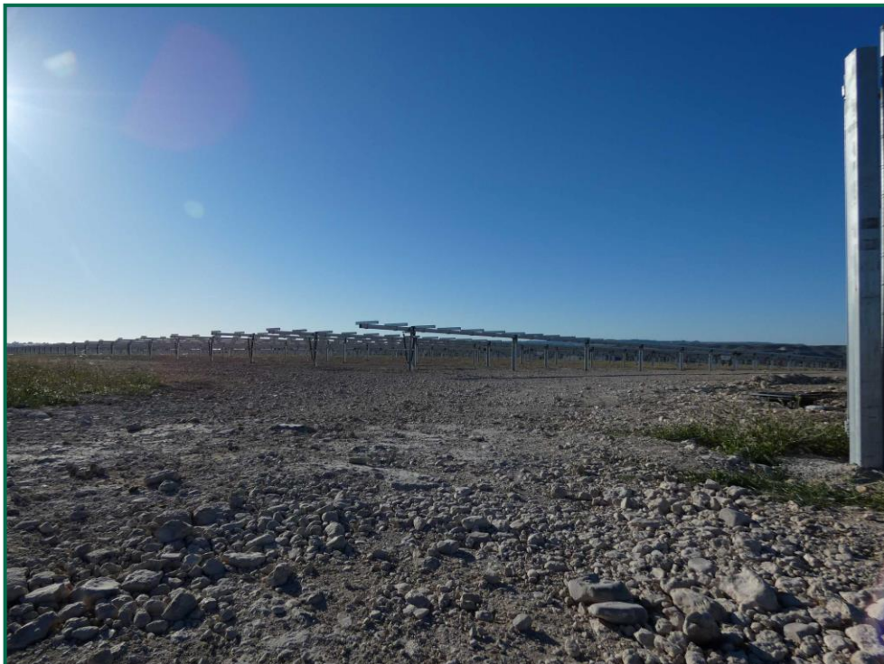
Fotografía 5. Superficie de la obra.
