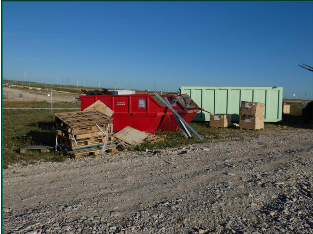
Fotografía 10. Contenedores de residuos.
