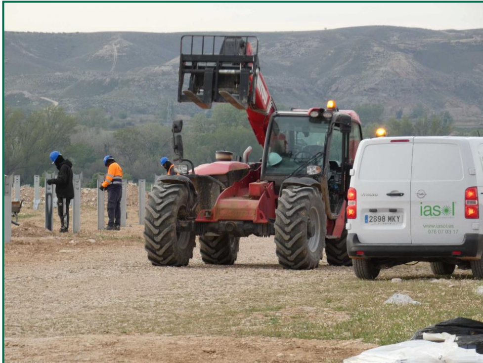
Fotografía 3. Maquinaria de obra.
