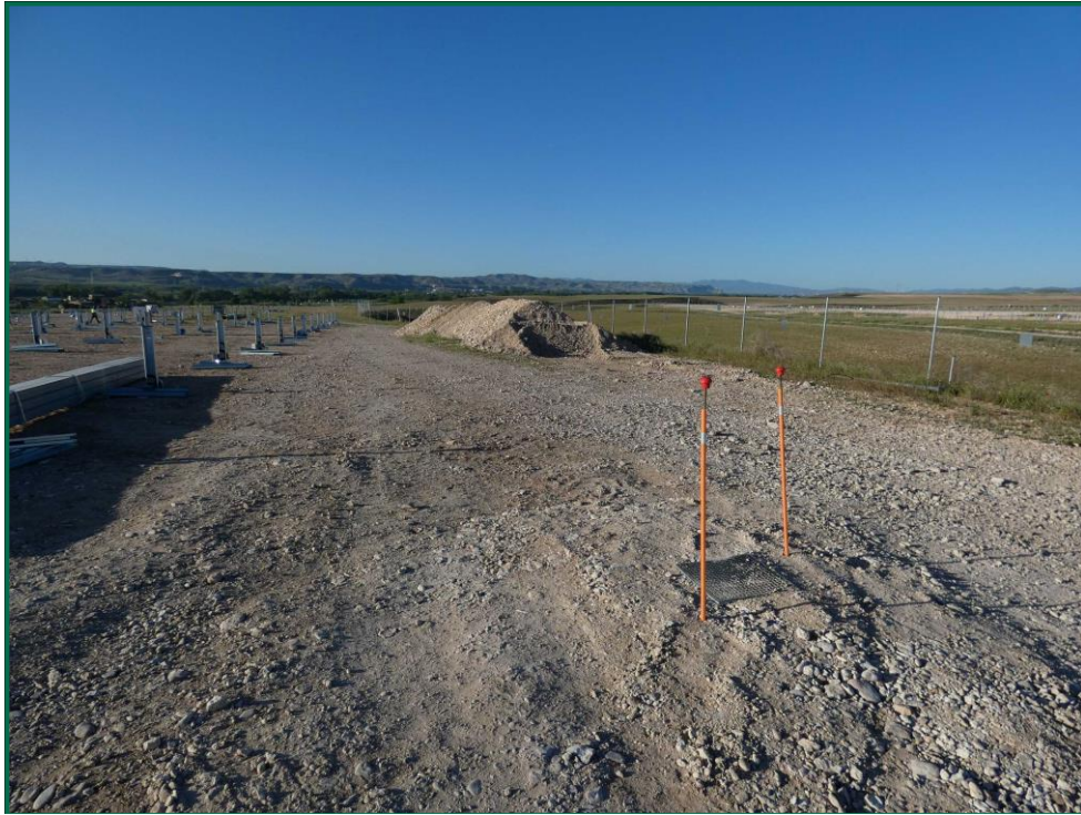
Fotografía 4. Acopios de tierra.
