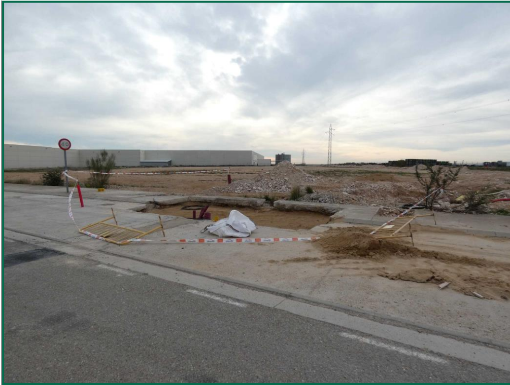
Fotografía 12. Balizamiento de la zanja.
