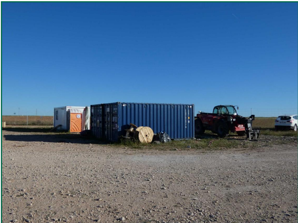
Fotografía 5. Casetas de gestión contenedores de materiales.
