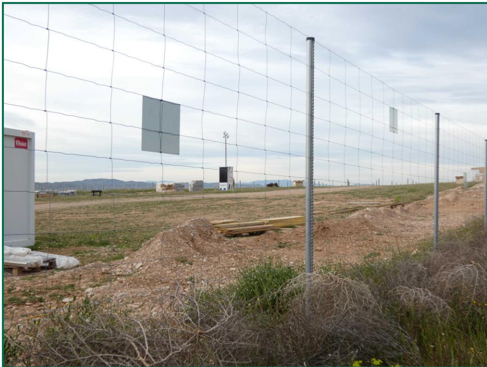
Fotografía 9. Vallado perimetral y placas anticolidión.
