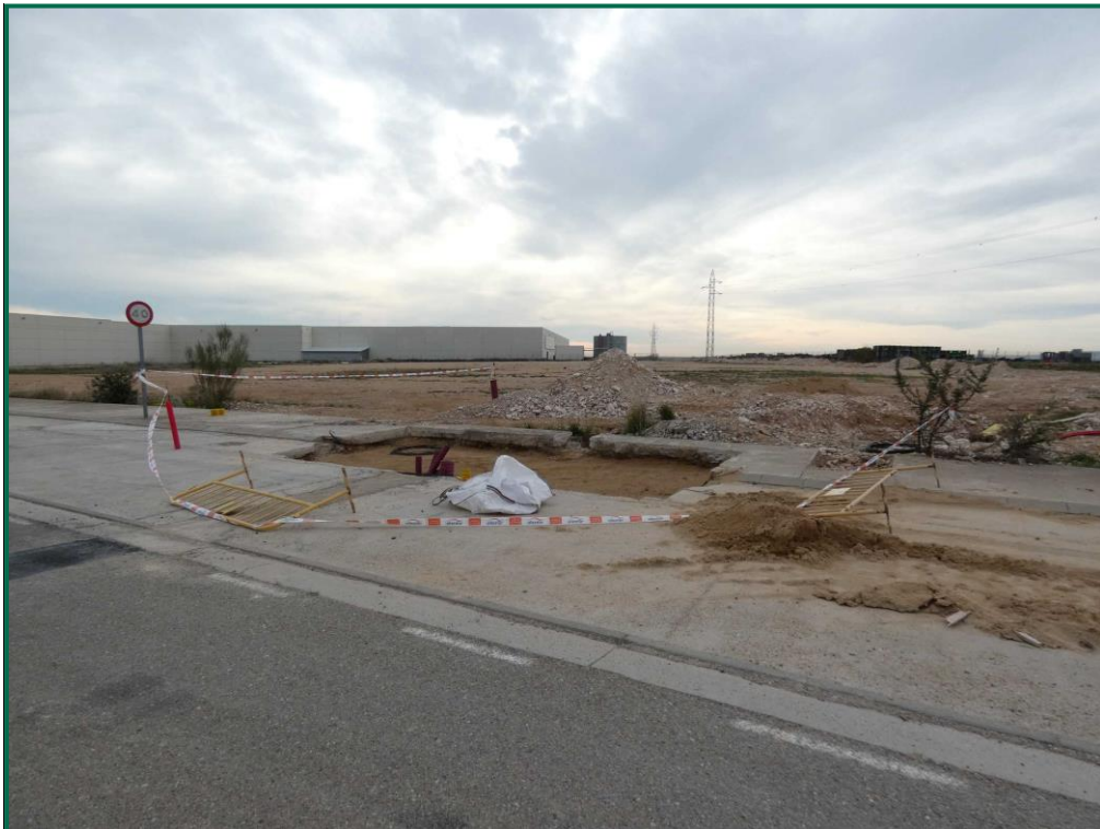
Fotografía 18. Balizamiento de la zanja.
