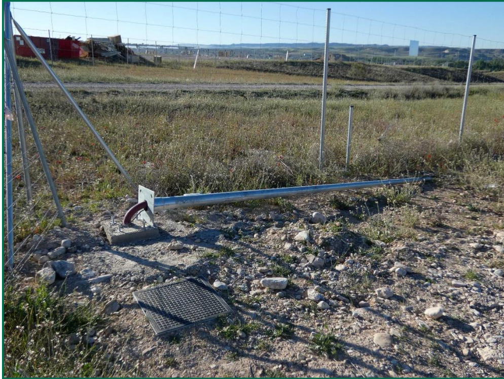
Fotografía 6. Estructura para las cámaras de vigilancia.
