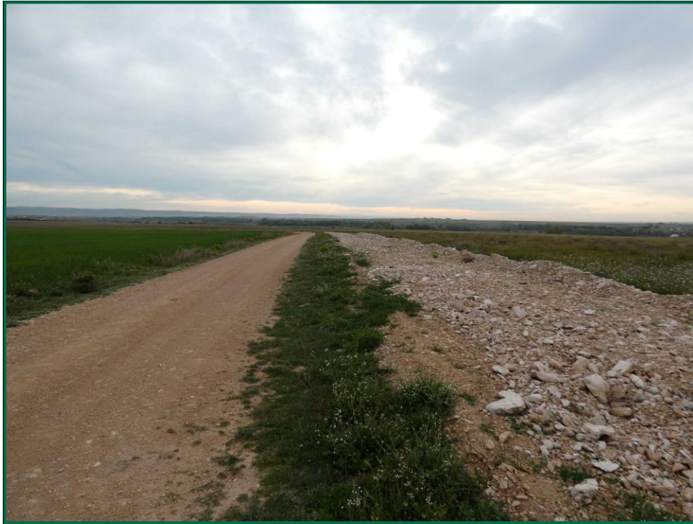
Fotografía 19. Tapado de zanjas
