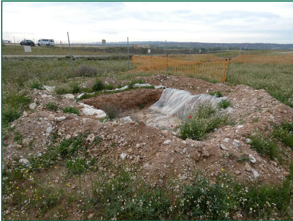
Fotografía 12. Balsa de limpieza.
