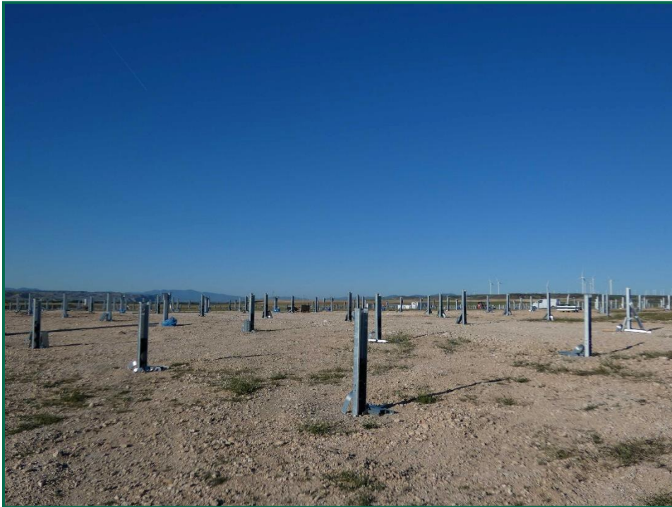
Fotografía 7. Superficie de la obra.
