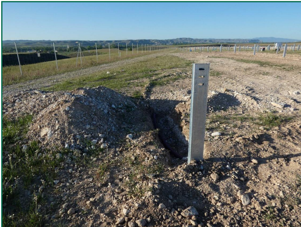
Fotografía 3. Acopios de tierra y poste vertical.
