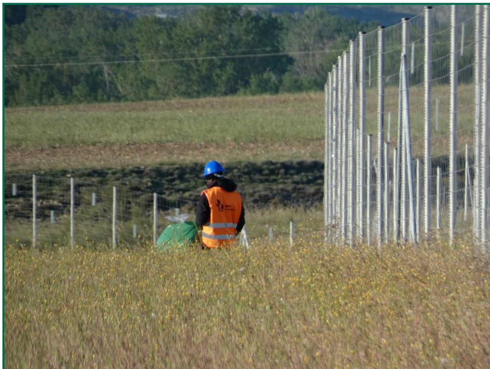
Fotografía 13. Personal de obra recogiendo los restos de embalaje.
