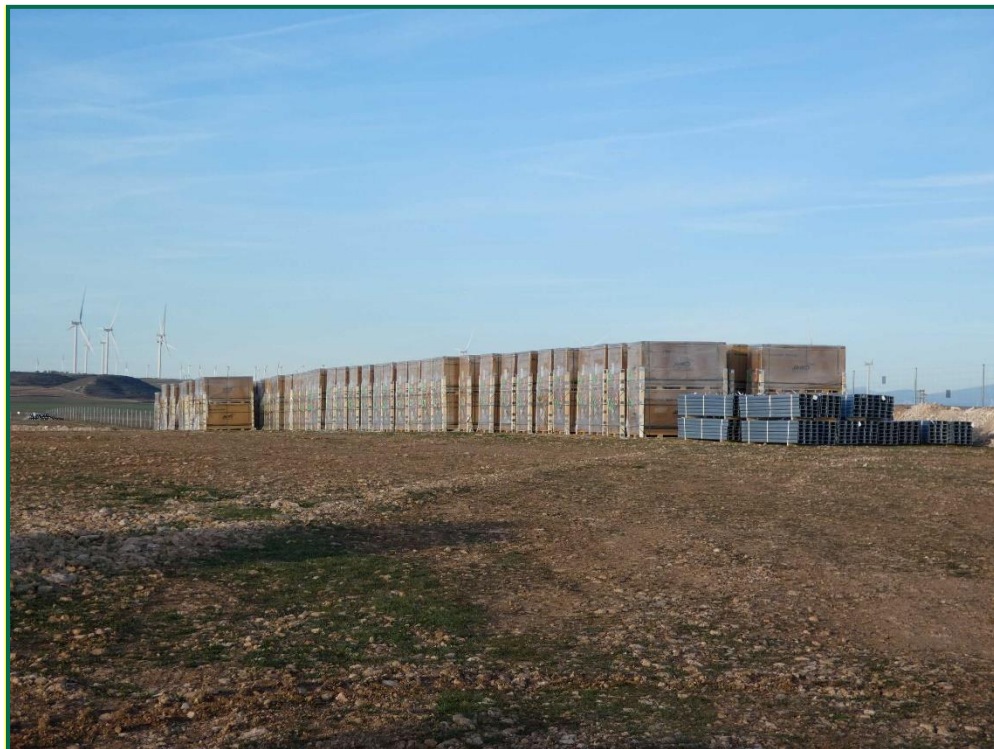
Fotografía 15. Recepción de materiales.
