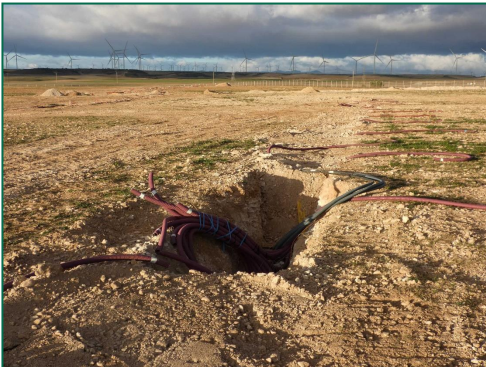
Fotografía 5. Colocación del cableado.
