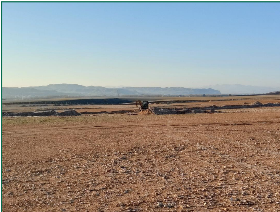
Fotografía 6. Superficie de la obra.
