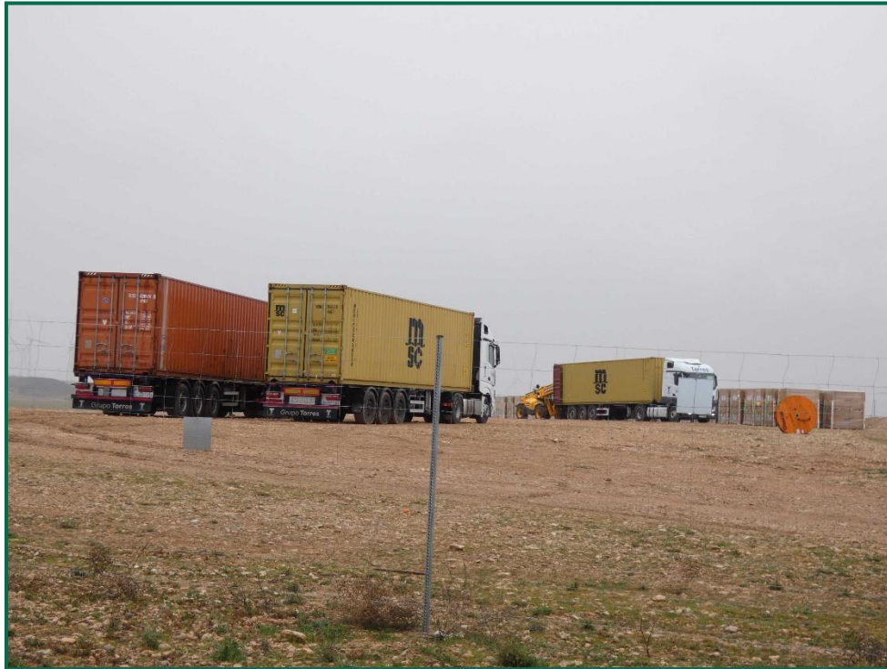
Fotografía 3. Recepción de materiales.
