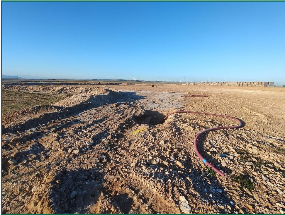
Fotografía 4. Tapado de zanjas.
