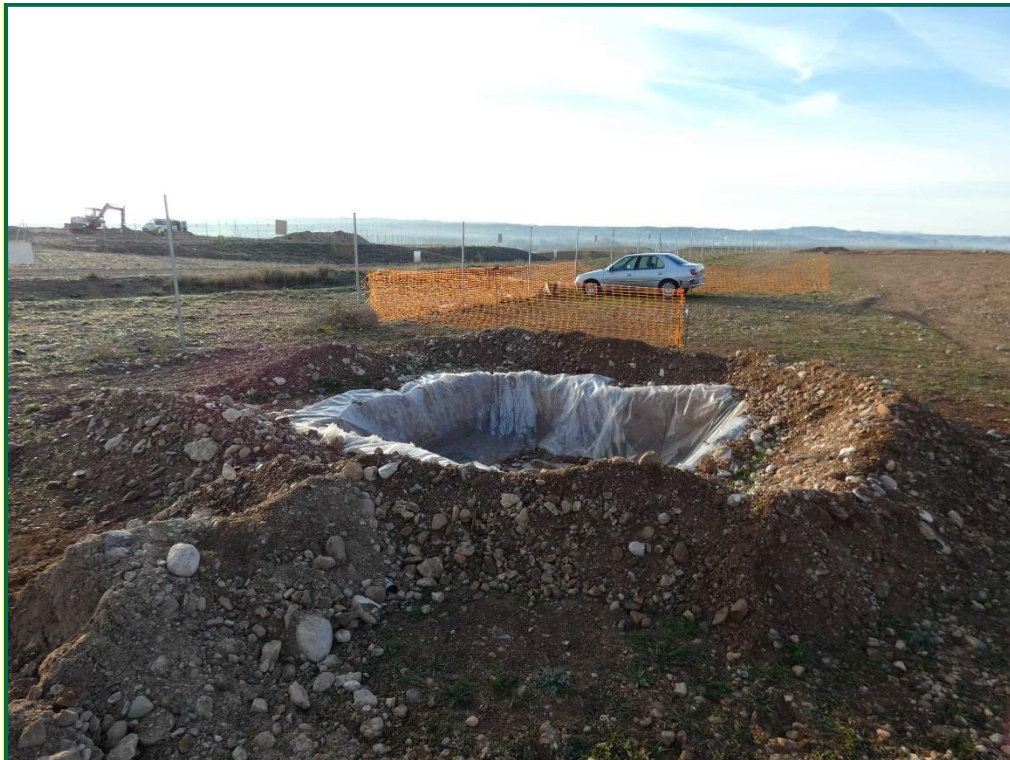
Fotografía 13. Balsa de limpieza.
