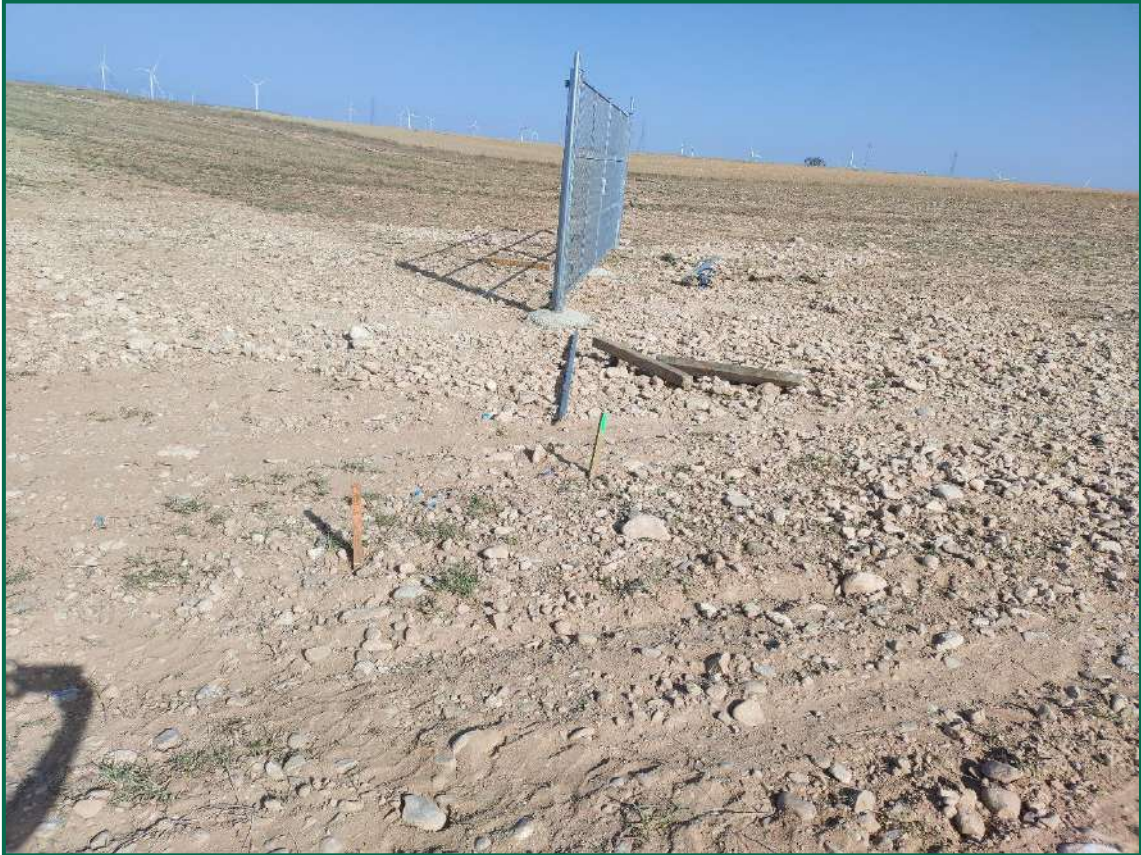
Fotografía 2. Jalonamiento y colocación de la puerta de acceso.
