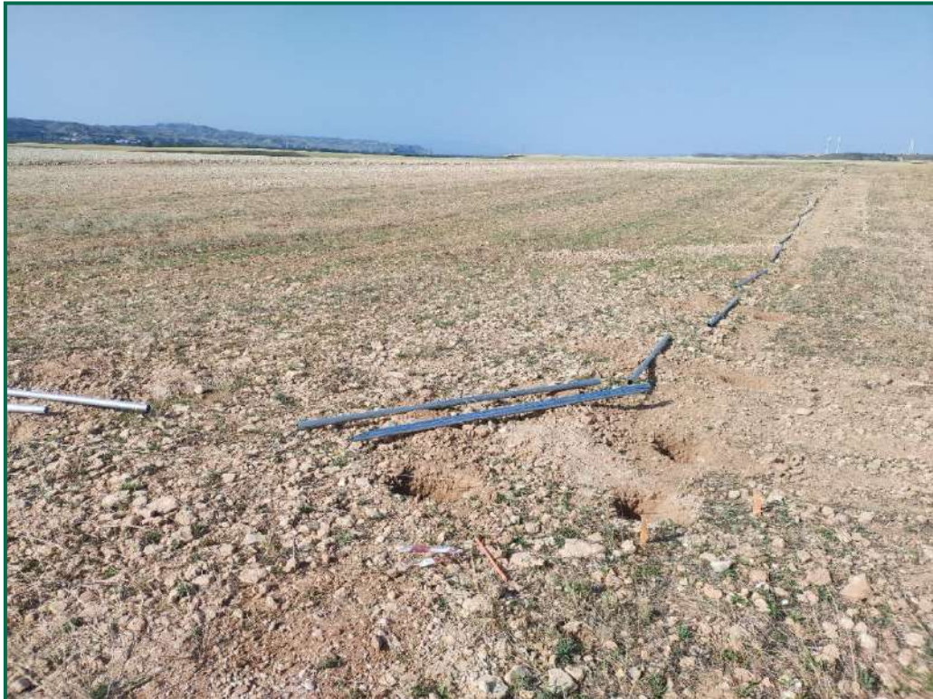
Fotografía 4. Superficie de la planta y realización de hoyos.
