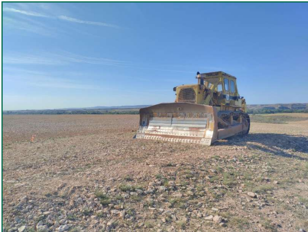
Fotografía 3. Máquina de retirada de tierra.
