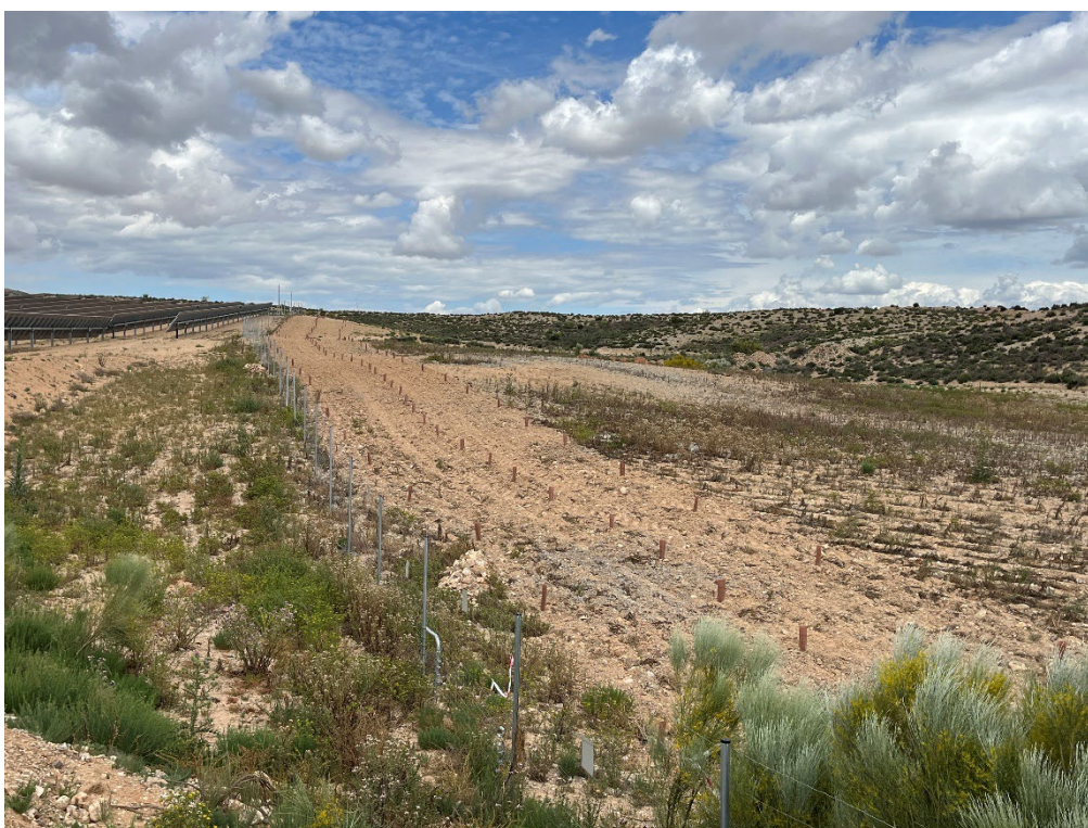
Figura 2 Ejecución de la pantalla vegetal
