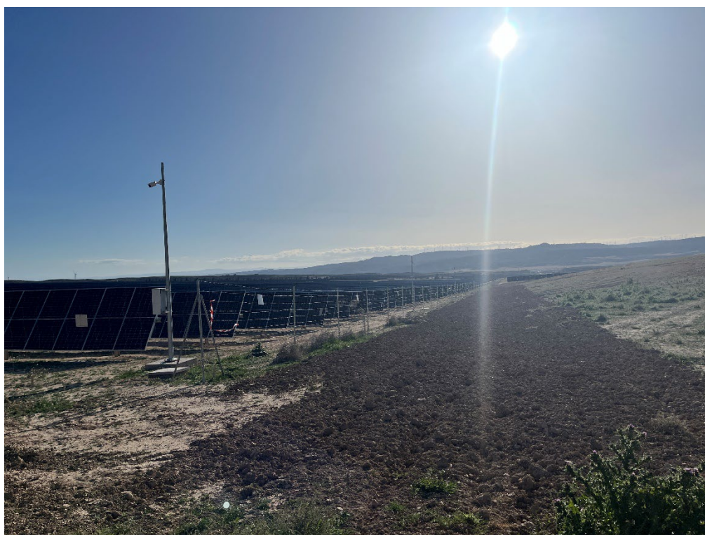
Figura 2 Preparación del terreno para la ejecución de la pantalla vegetal
