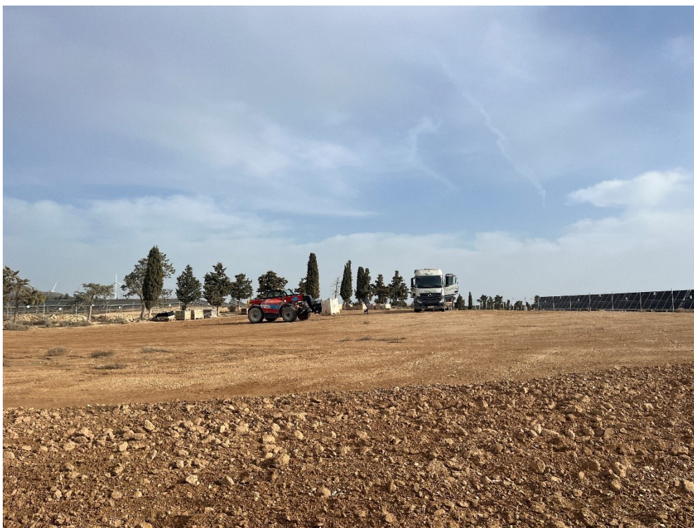
Figura 3 Retirada del punto limpio de residuos no peligrosos
