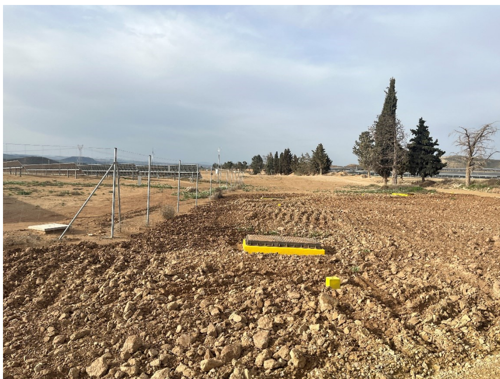
Figura 2 Restauración de las zonas afectadas
