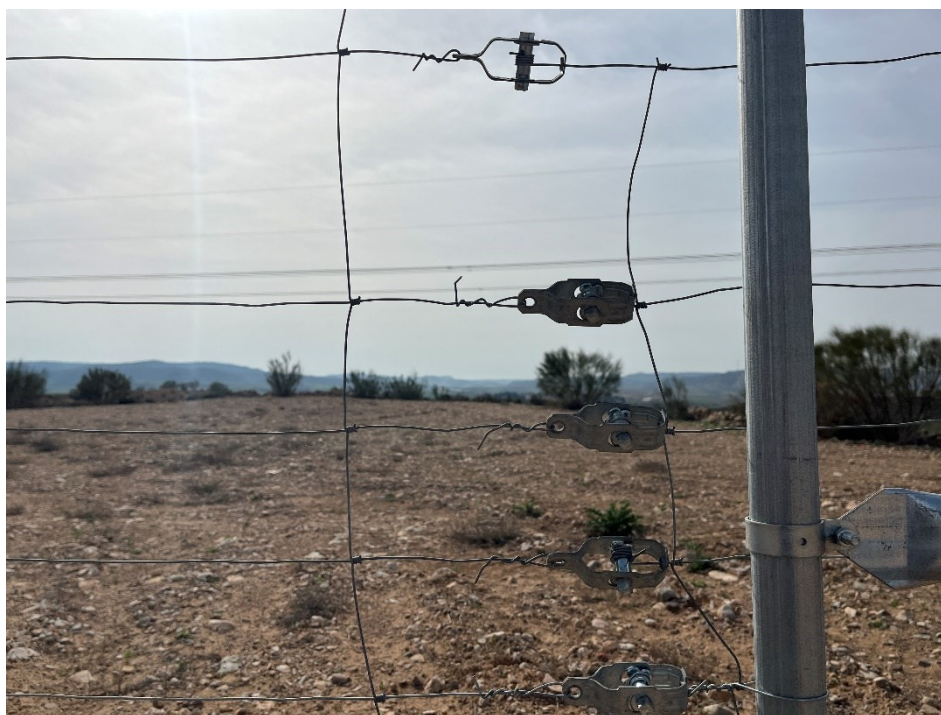
Figura 4 Elementos punzantes del vallado perimetral
