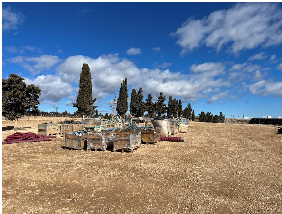
Figura 5 Acopio del material de construcción
