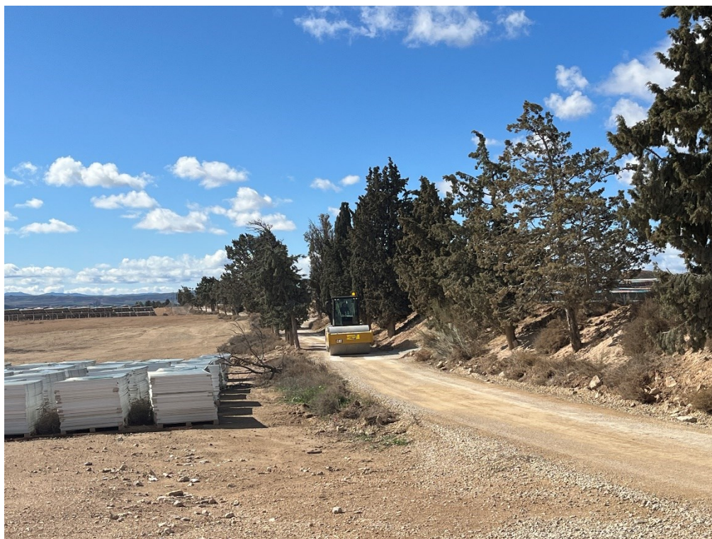
Figura 2 Restauración de los viales
