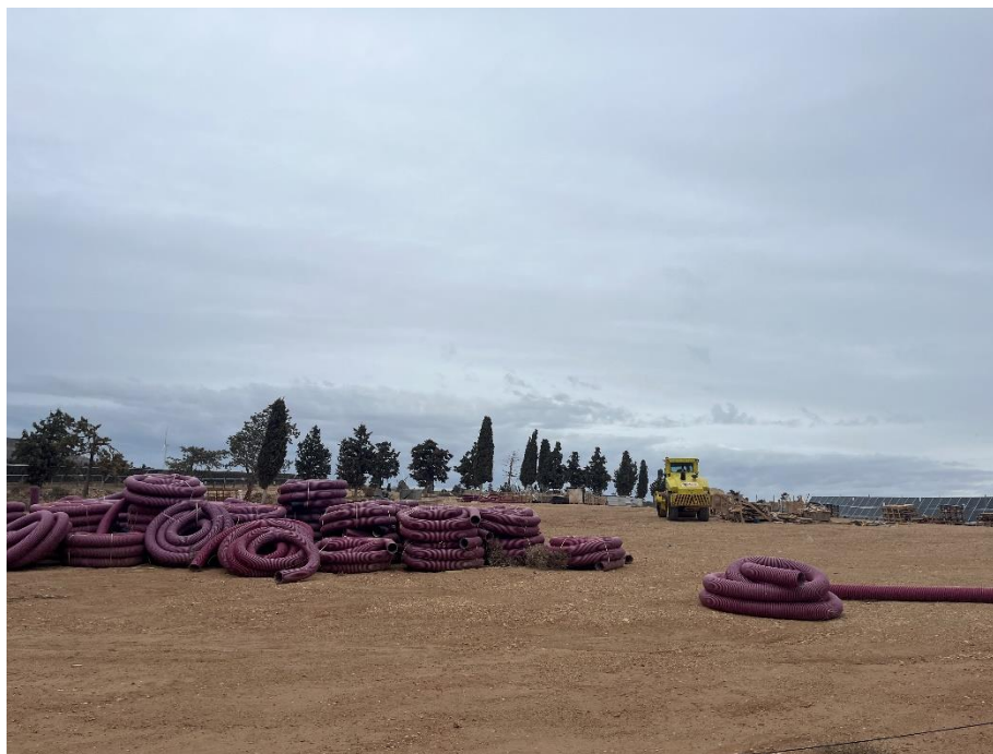
Figura 5 Acopio del material de construcción
