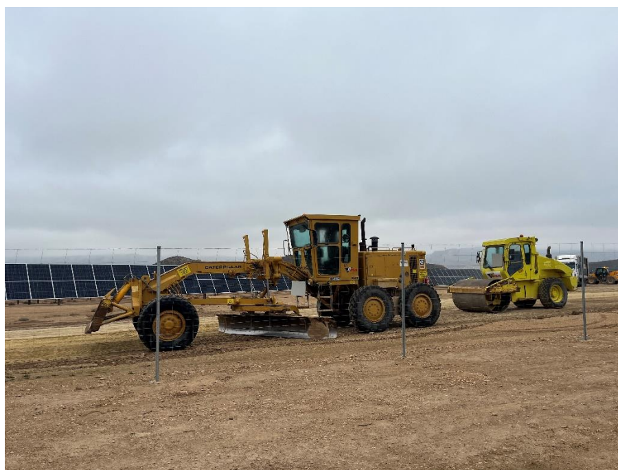
Figura 6 Restauración de los viales
