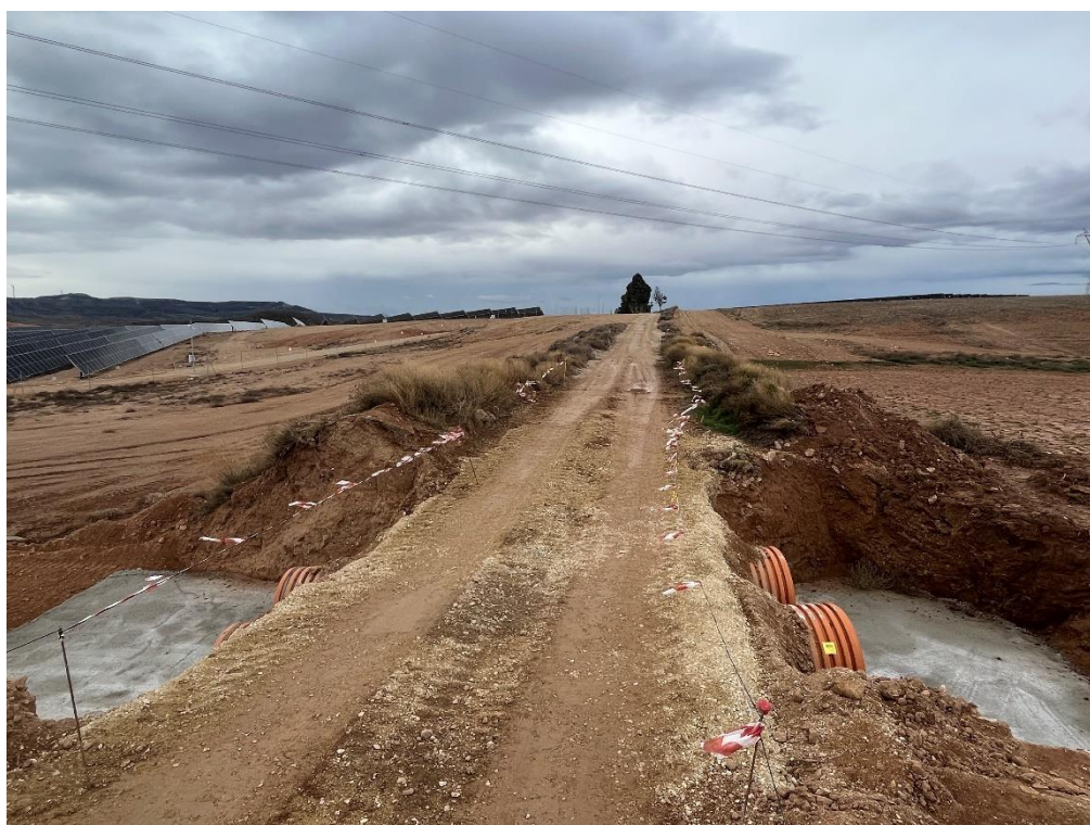
Figura 2 Instalación de tubos de drenaje
