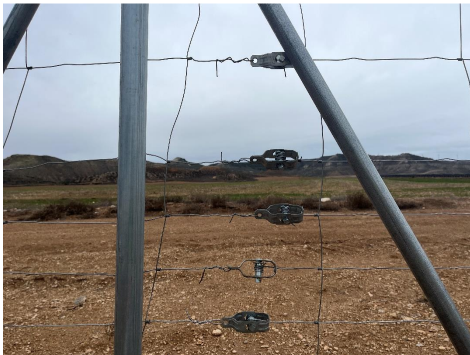
Figura 4 Elementos punzantes del vallado perimetral
