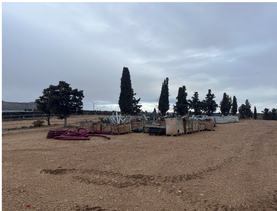
Figura 5 Acopio del material de construcción
