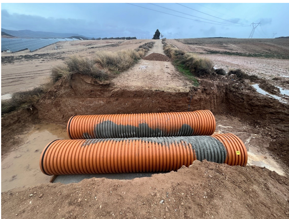
Figura 2 Instalación de tubos de drenaje
