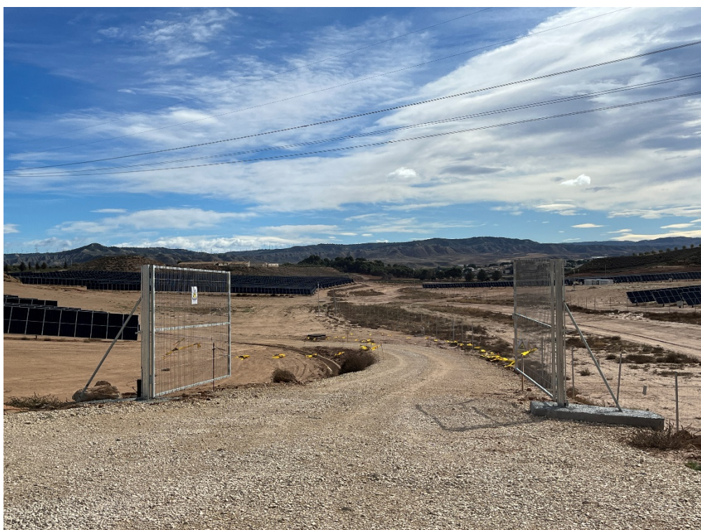
Figura 2 Cimentación de las puertas
