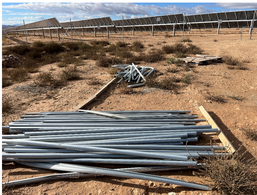
Figura 6 Acopio del material de construcción
