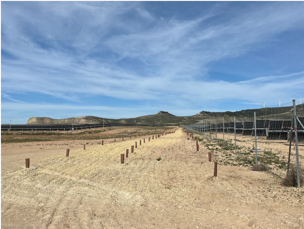
Figura 2 Ejecución de la pantalla vegetal
