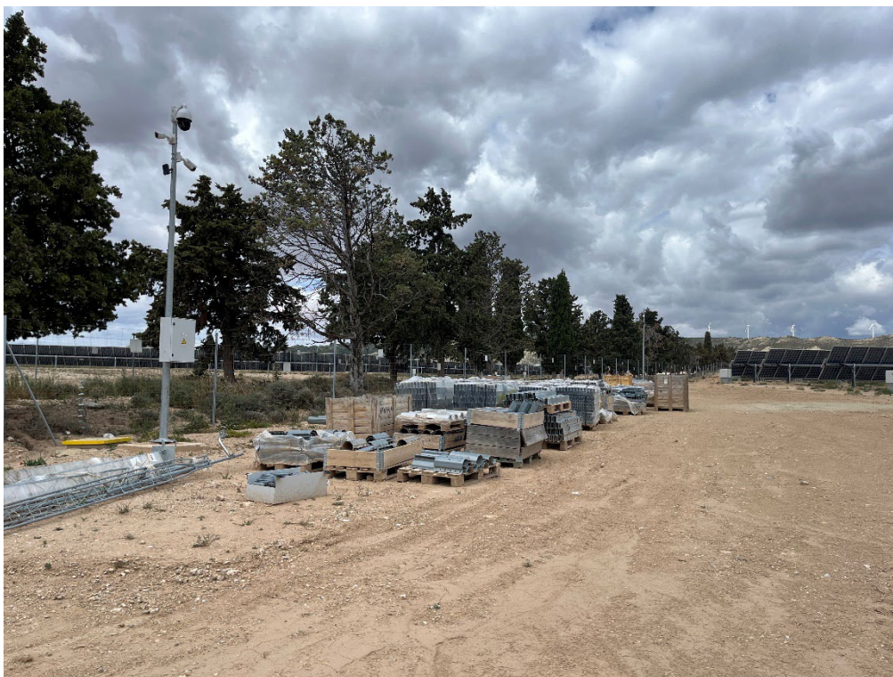
Figura 13 Acopio del material de construcción
