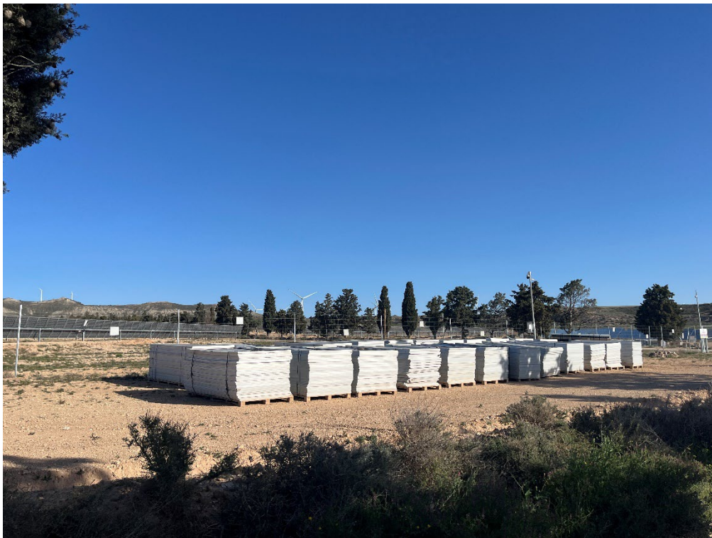
Figura 5 Acopio del material de construcción
