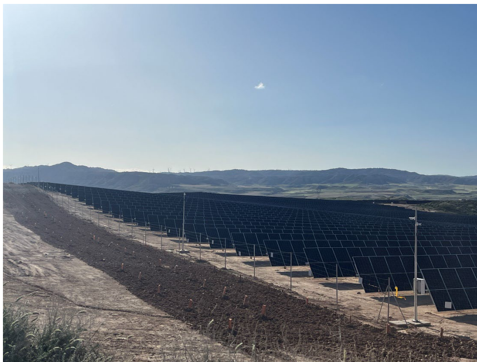
Figura 4 Ejecución de la pantalla vegetal
