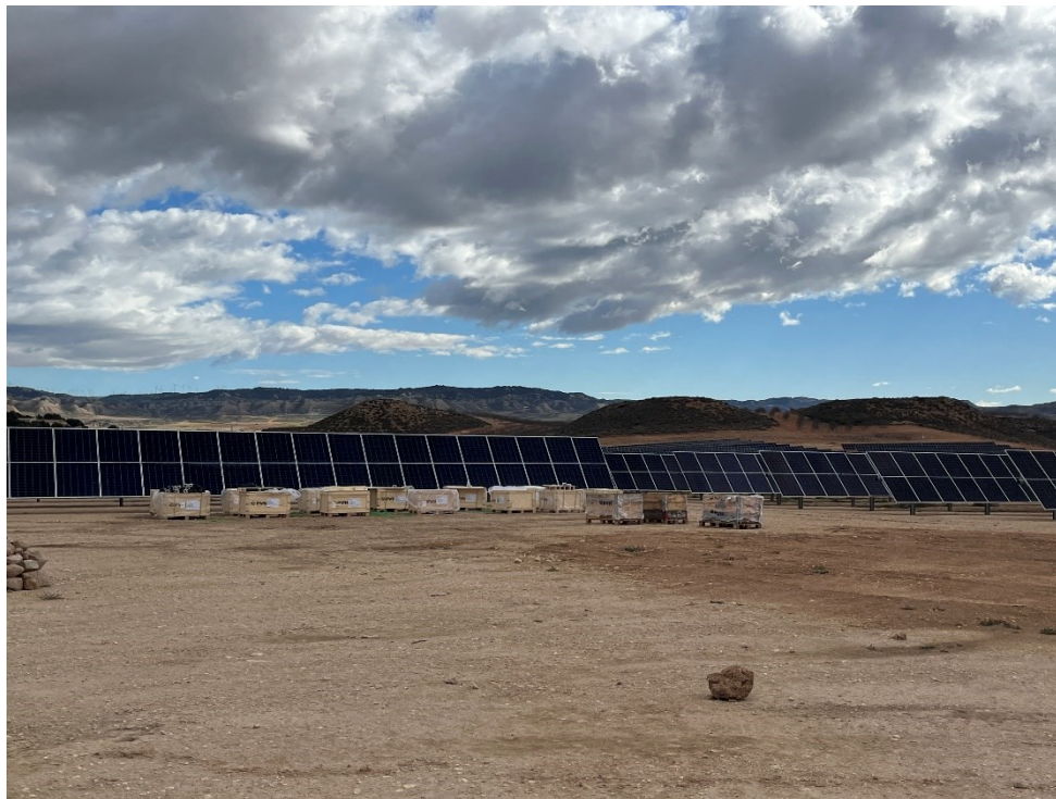
Figura 5 Acopio del material de construcción
