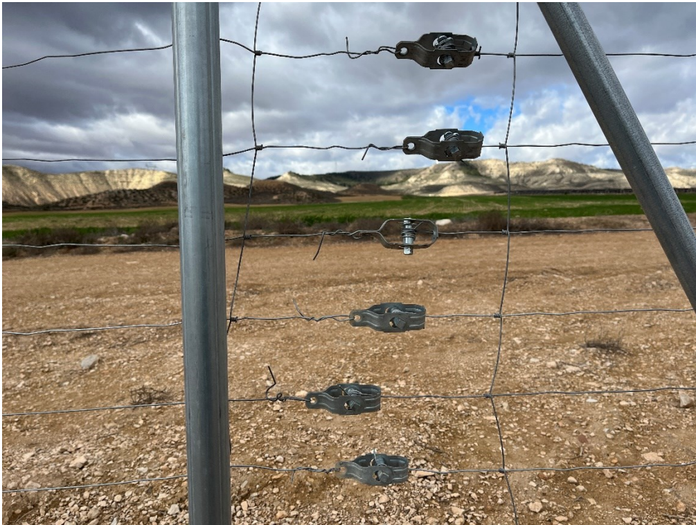
Figura 6 Elementos punzantes en el vallado perimetral
