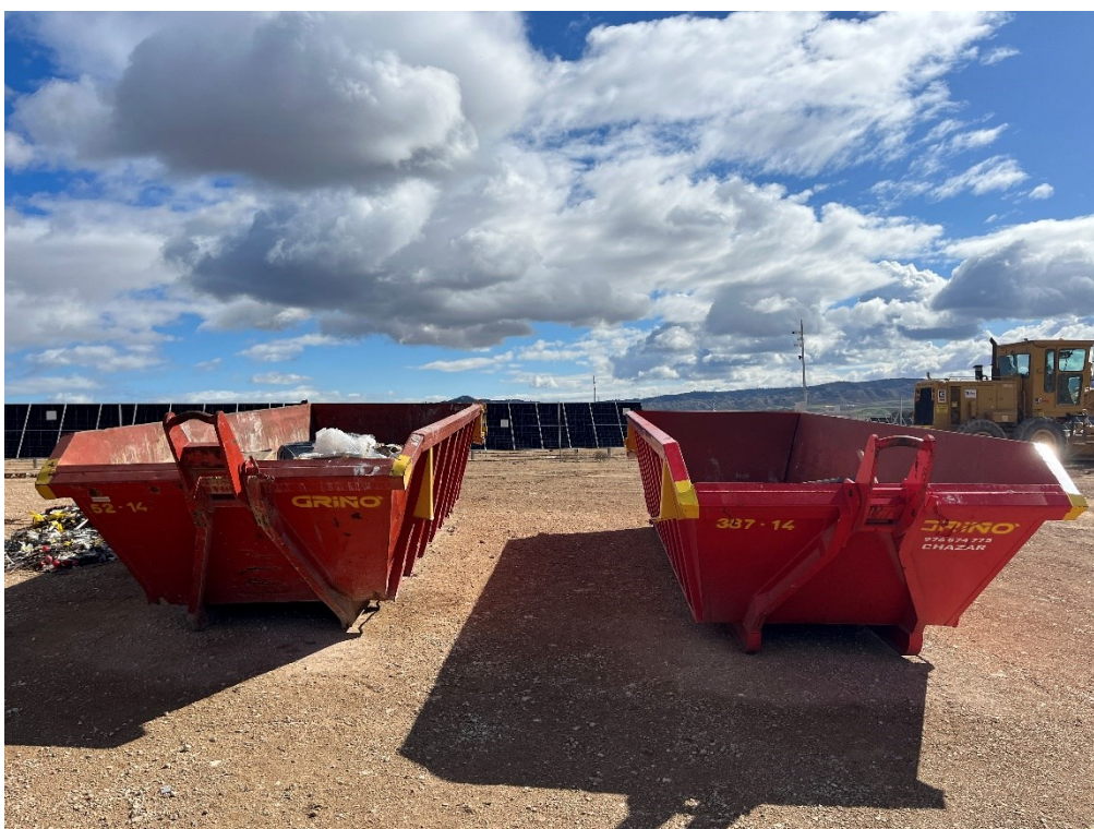
Figura 3 Punto limpio de residuos no peligrosos
