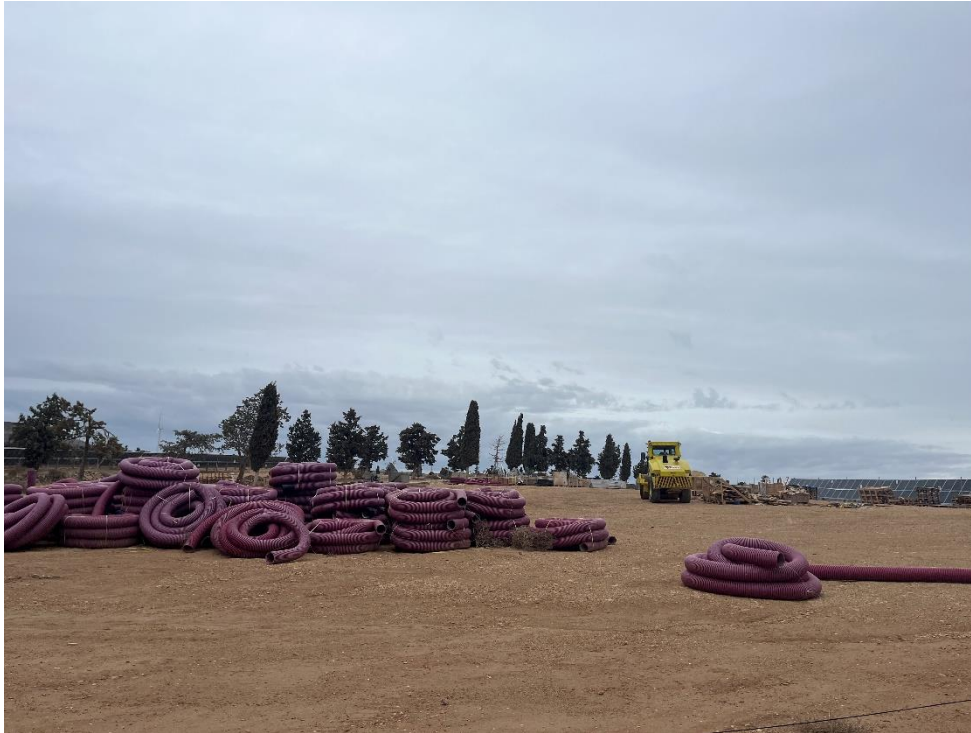
Figura 5 Acopio del material de construcción
