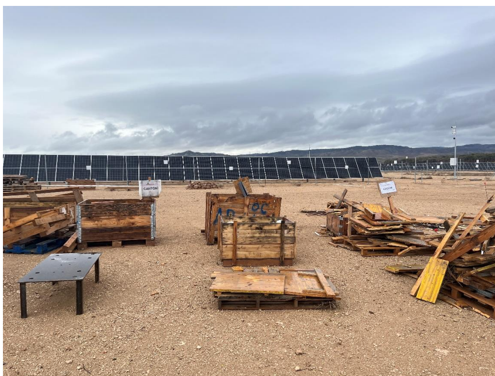
Figura 3 Punto limpio de residuos no peligrosos
