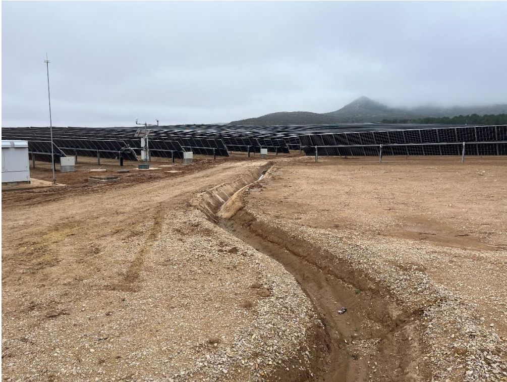
Figura 8 Apertura de cunetas
