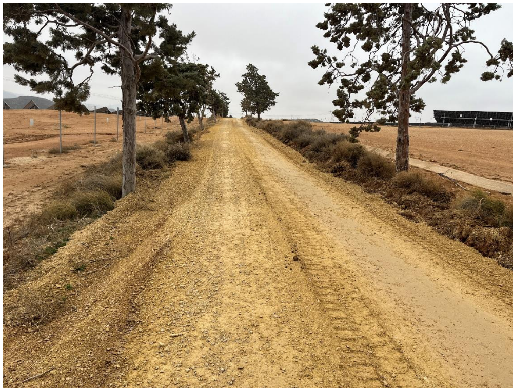
Figura 2 Cimentación del vial
