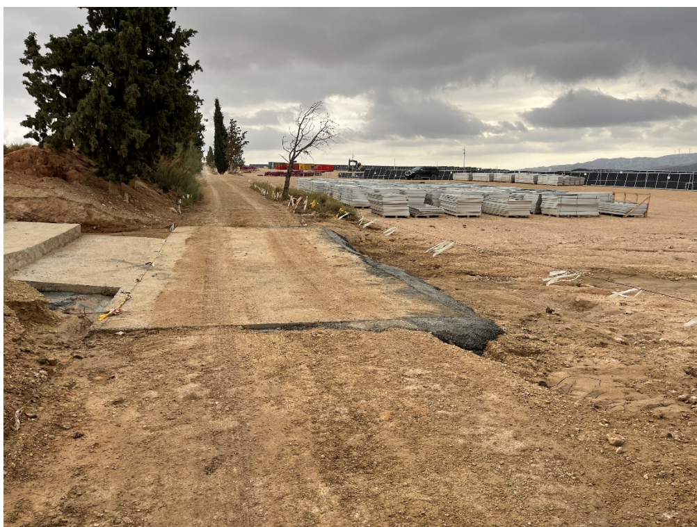
Figura 2 Cimentación del vial interno
