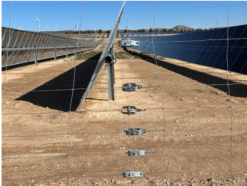
Figura 4 Elementos punzantes en el vallado perimetral
