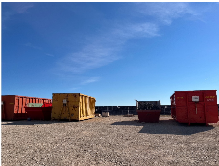
Figura 5 Punto limpio de residuos no peligrosos
