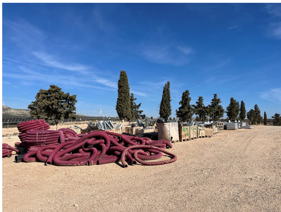
Figura 6 Acopio del material de construcción
