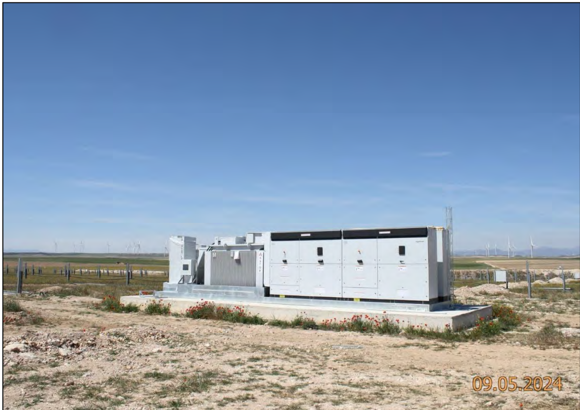
Ilustración 1. Instalación de la última Power Station.
