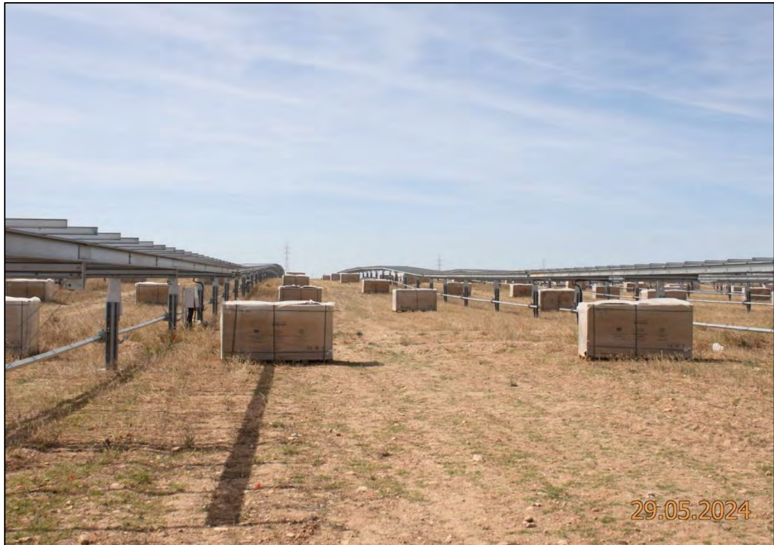
Ilustración 4. Paneles preparados para comenzar con la instalación.
