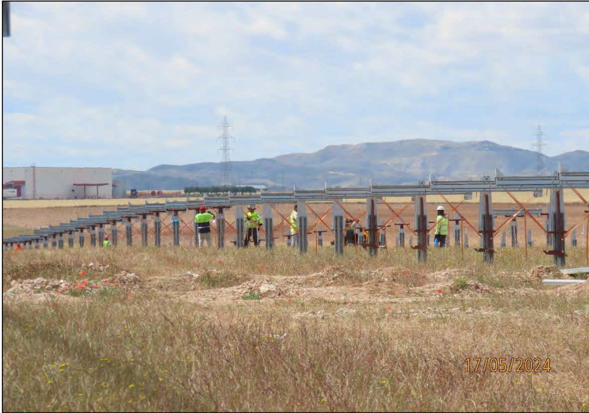
Ilustración 2. Trabajos de montaje de las estructuras de los seguidores.
