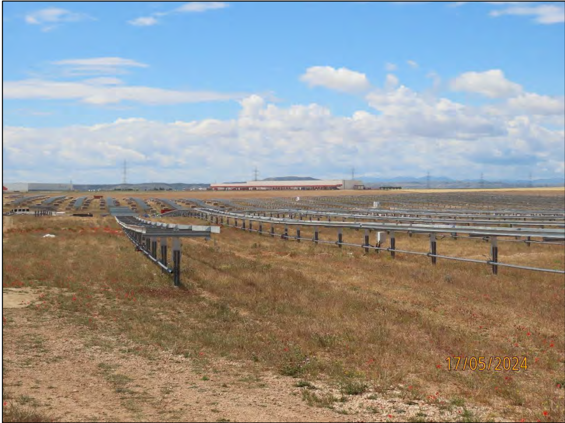
Ilustración 6. Estado actual del parque.
