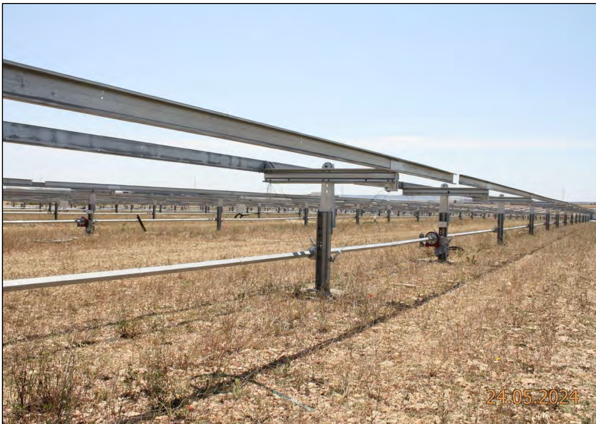
Ilustración 3. Trabajos de montaje de las estructuras de los seguidores.
