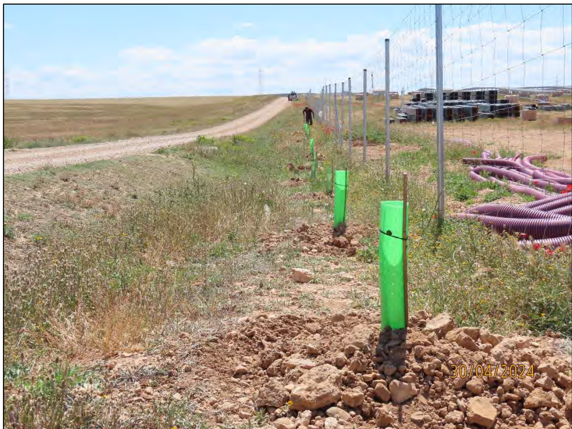
Ilustración 5. Instalación de la pantalla visual.
