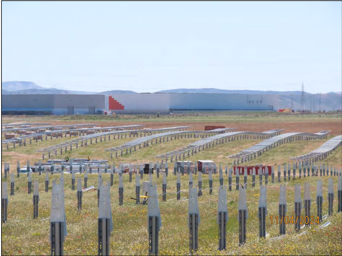
Ilustración 6. Estado actual del parque.
