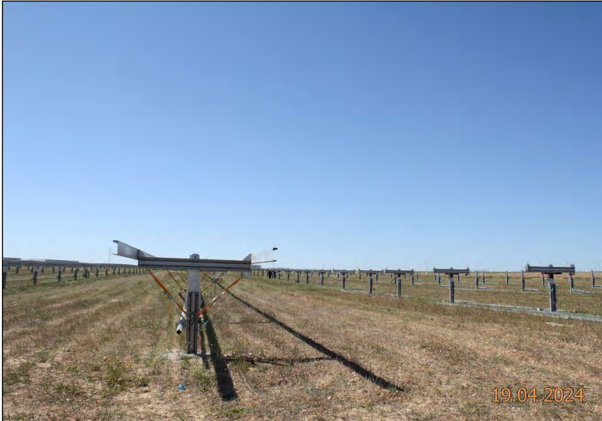
Ilustración 2. Montaje de las estructuras de los seguidores.
