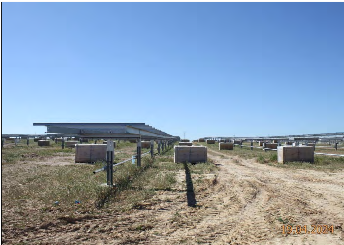
Ilustración 3. Paneles preparados para comenzar con la instalación.
