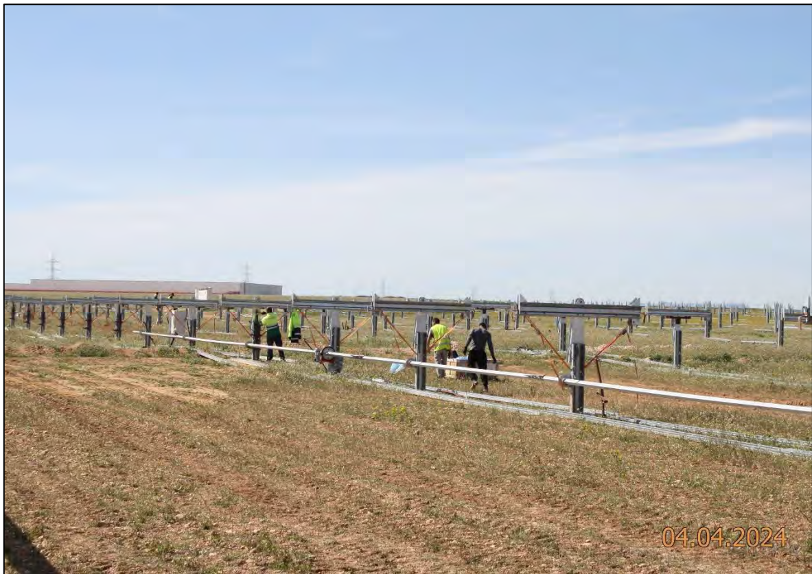
Ilustración 1. Montaje de las estructuras de los seguidores.
