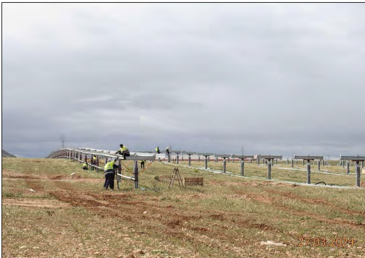
Ilustración 5. Montaje de las estructuras de los seguidores.
