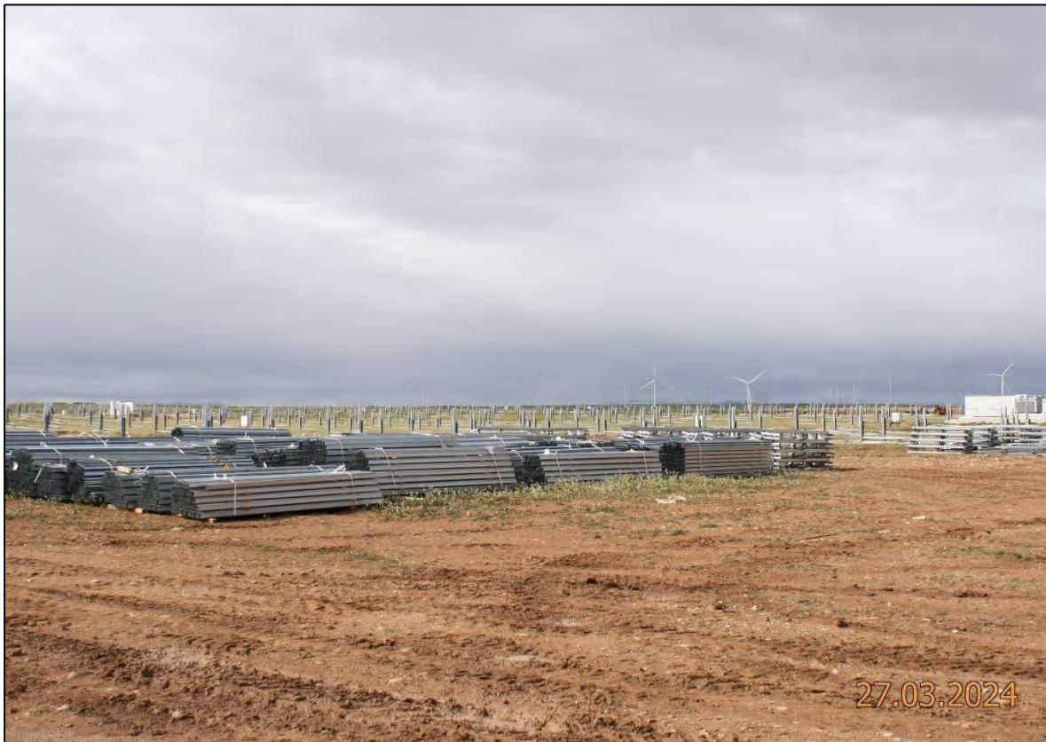
Ilustración 1. Recepción y acopio de materiales de obra.
