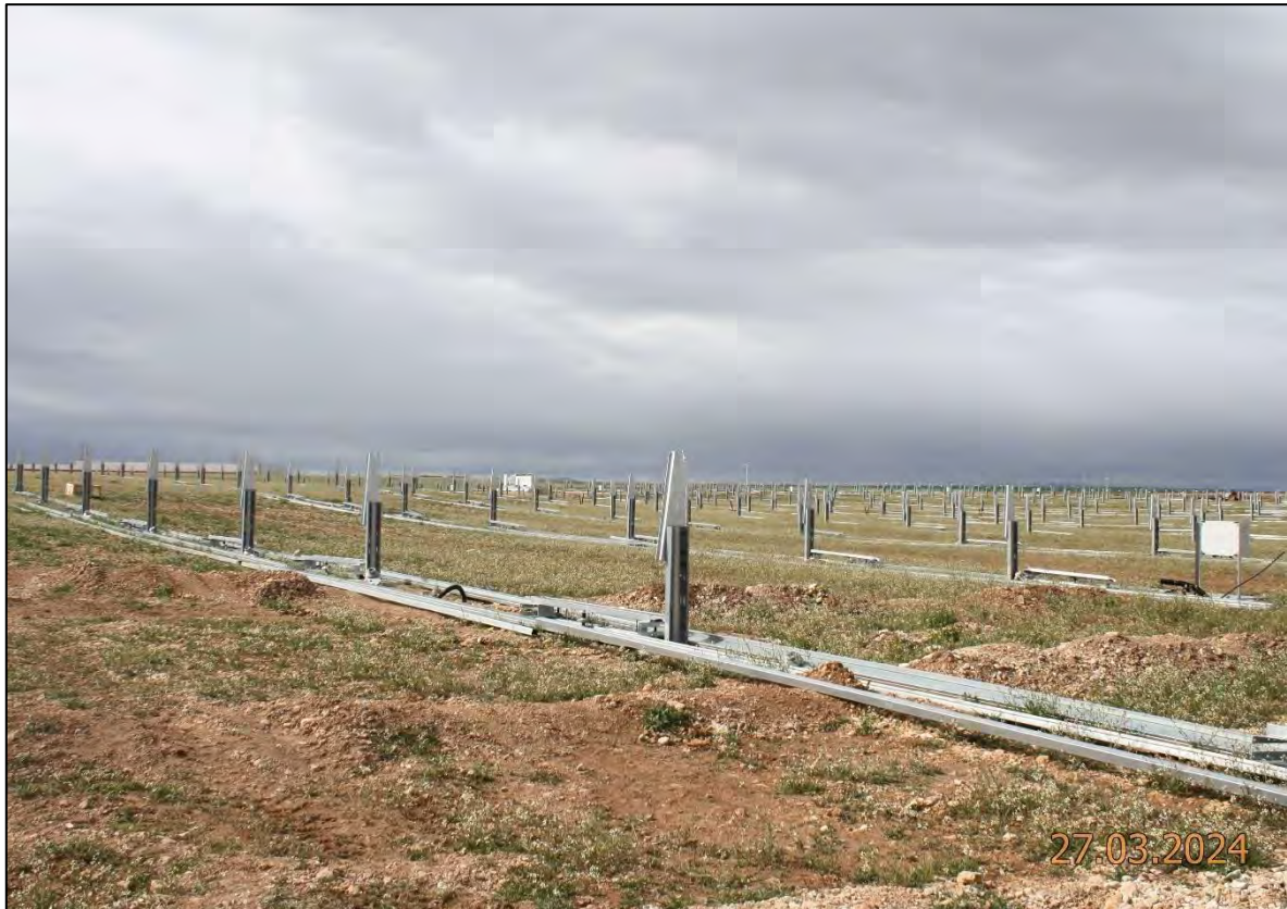
Ilustración 4. Preparación de las estructuras de los seguidores.
