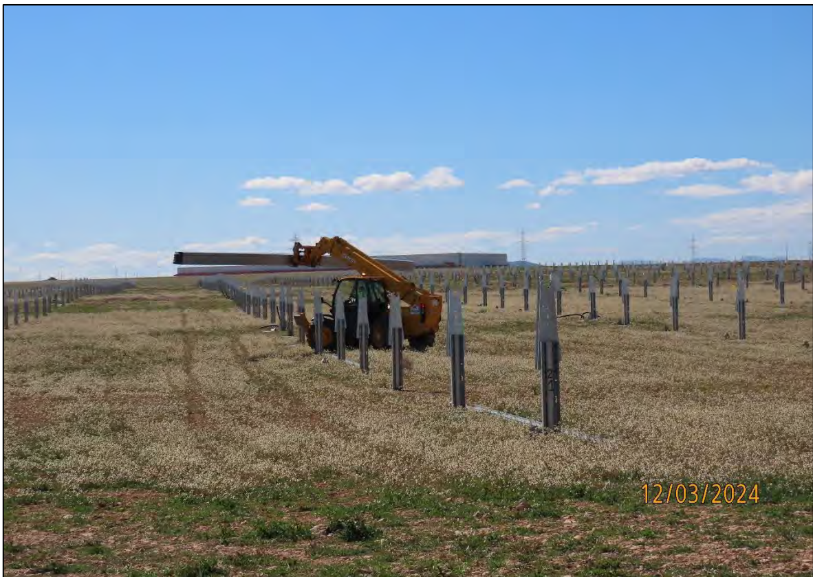
Ilustración 3. Preparación de las estructuras de los seguidores.
