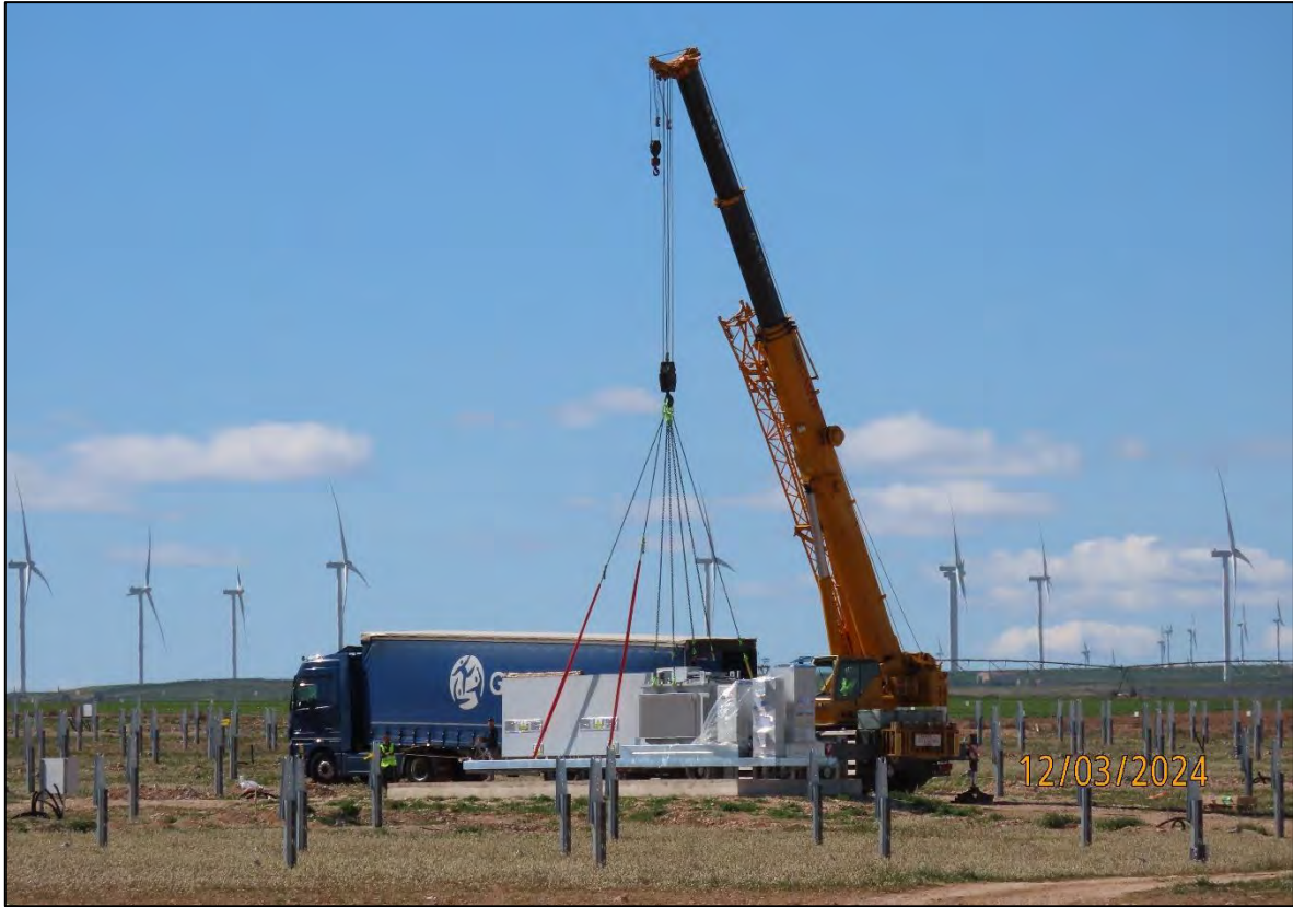
Ilustración 2. Instalación de la Power Station.
