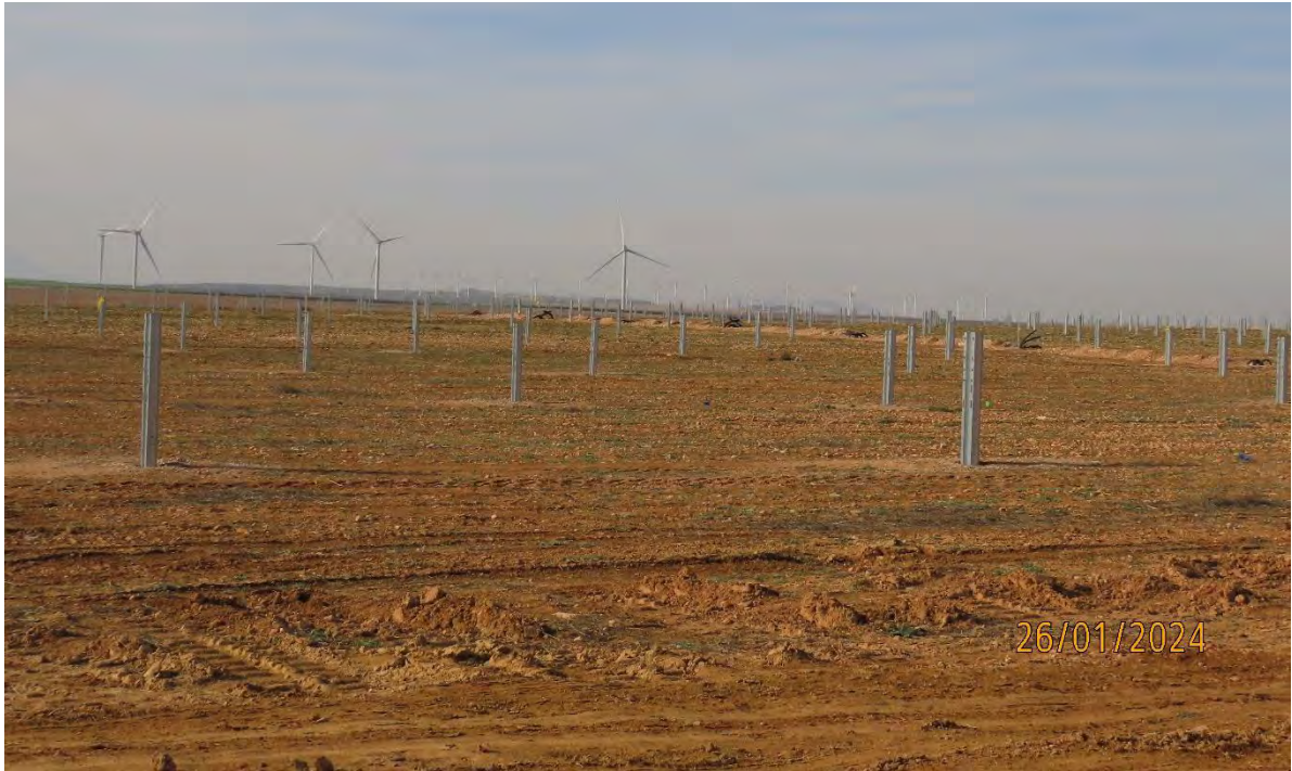
Ilustración 7. Finalización de los trabajos de hincado.
