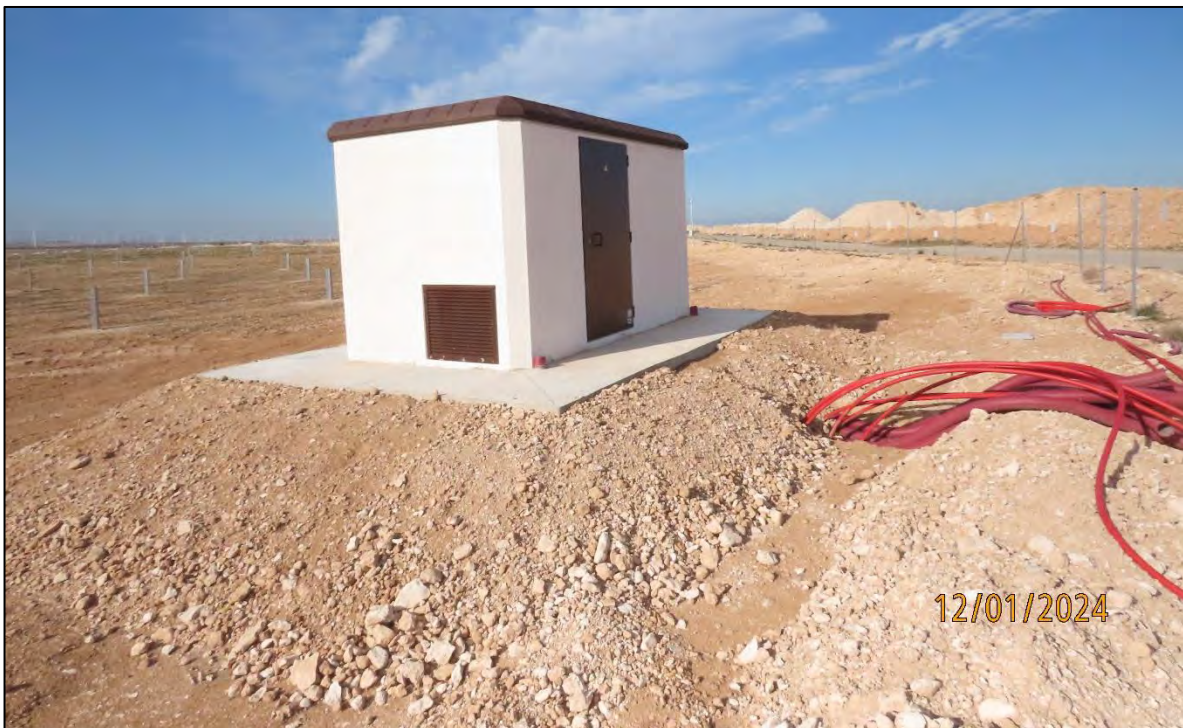
Ilustración 6. Cimentación de la base del Centro de Transformación.
