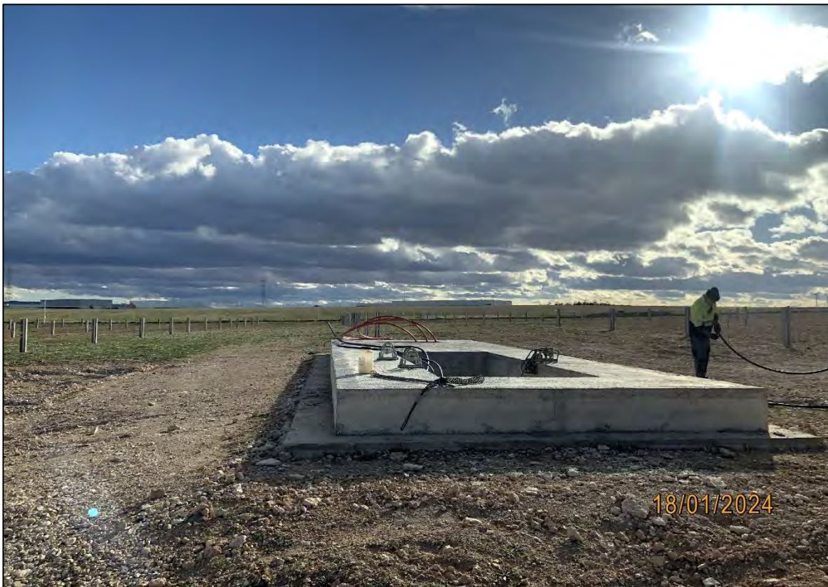
Ilustración 2. Instalación de cableado.
