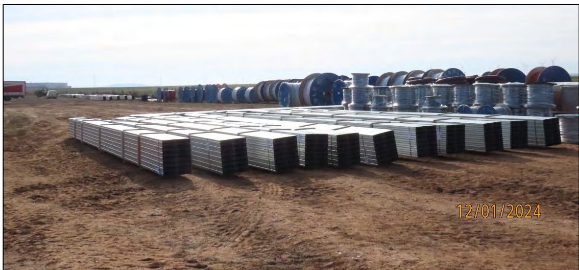
Ilustración 4. Acopio de materiales de obra.
