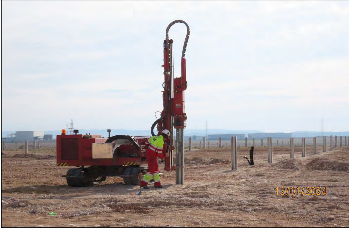
Ilustración 5. Trabajos de hincado
