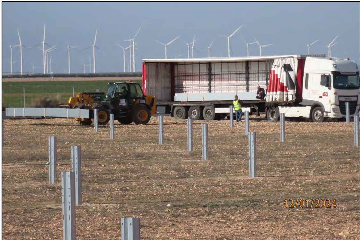
Ilustración 3. Recepción de materiales de obra.
