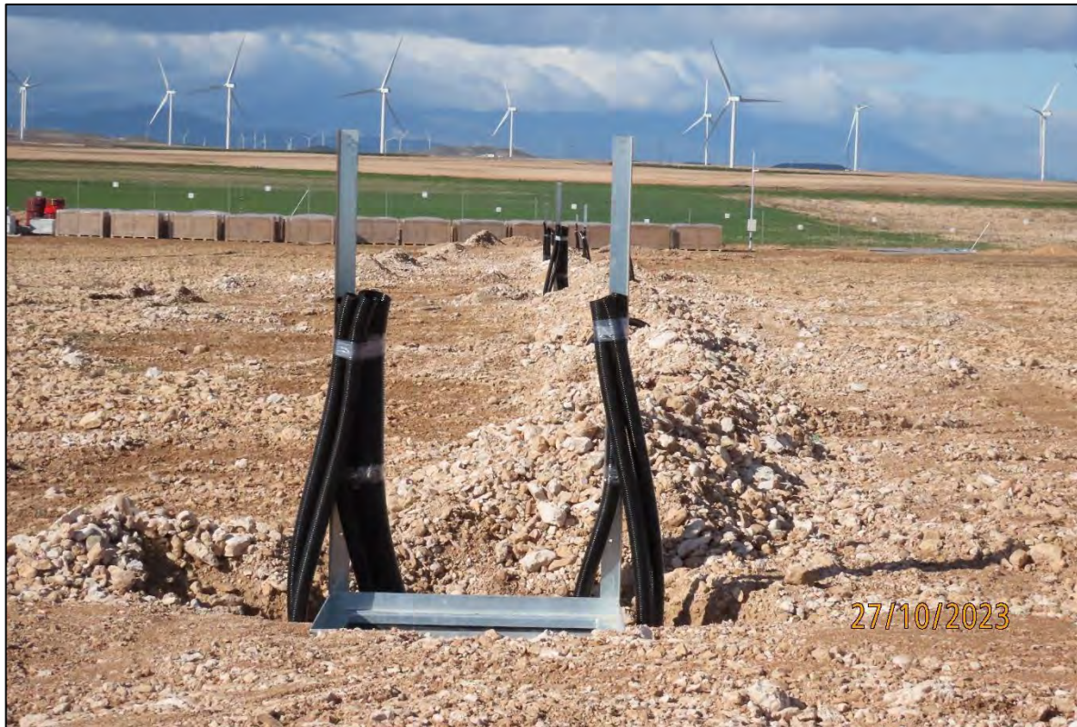
Ilustración 6. Zanja tapada.
