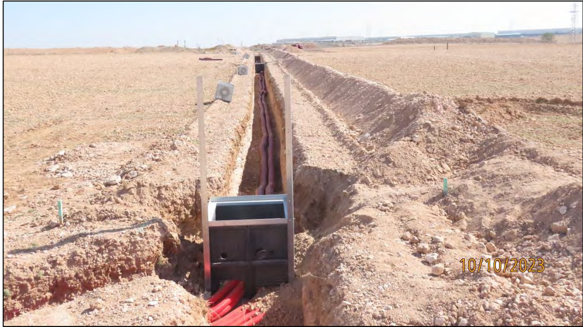
Ilustración 3. Colocación de tuberías de cableado y cajas de strings.
