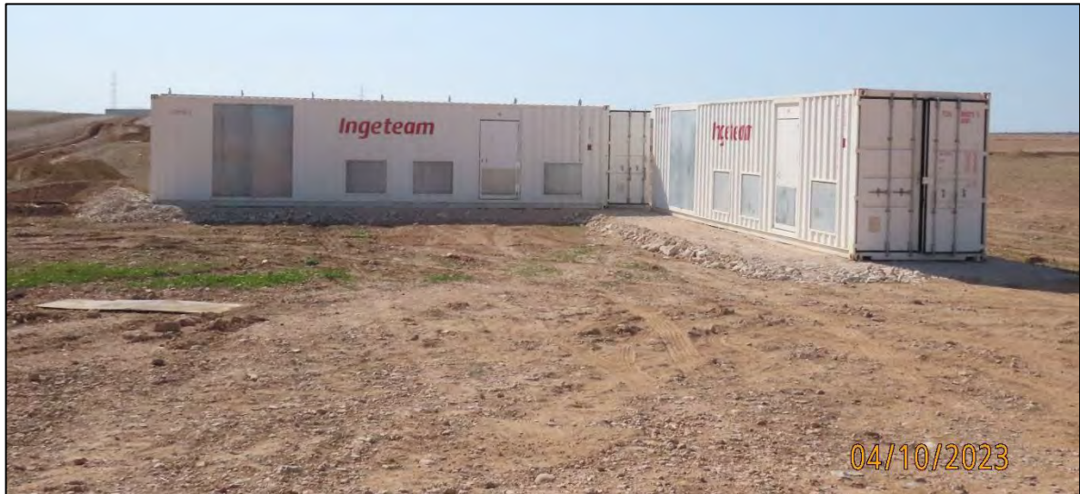
Ilustración 2. Casetas de obra.
