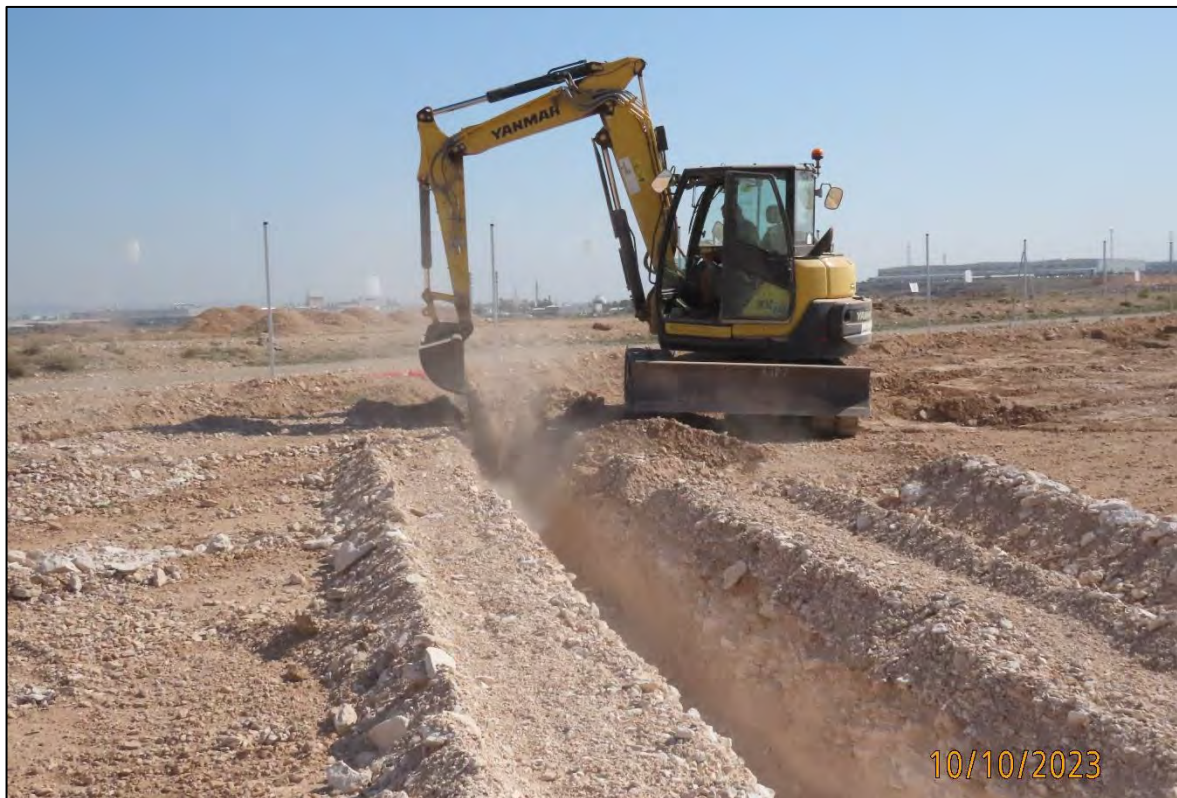
Ilustración 4. Tapado de zanjas.
