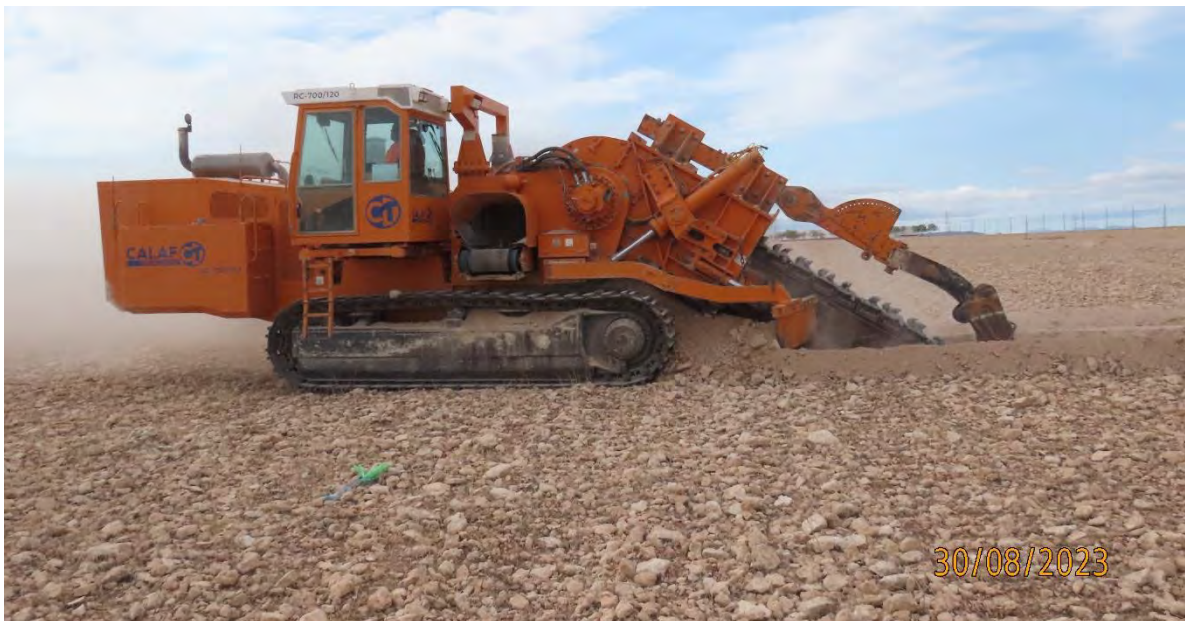
Ilustración 2. Apertura de zanjas con zanjadora.
