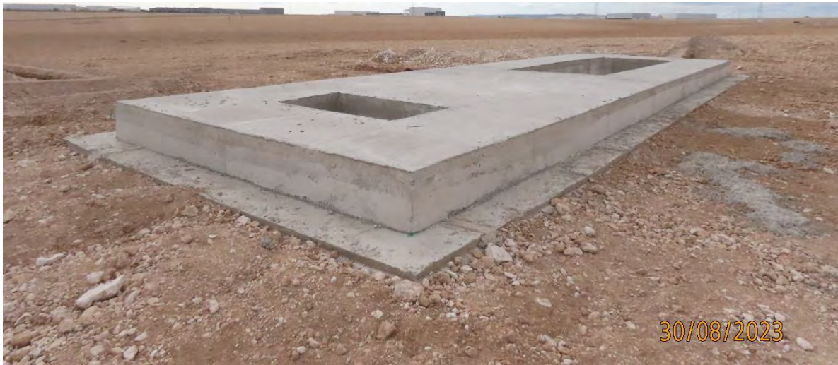
Ilustración 4. Cimentación de la base de las Power Station.
