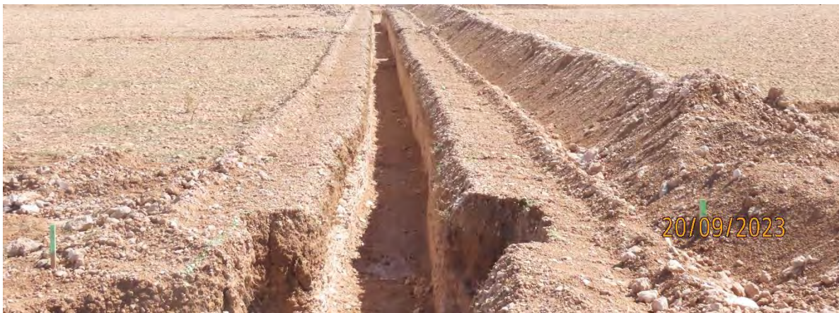
Ilustración 6. Acopio de tierra vegetal resultante de la apertura de zanjas.
