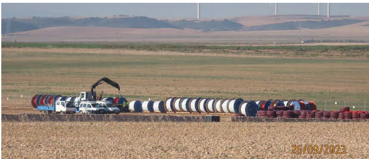
Ilustración 5. Recepción y acopio de materiales en la superficie habilitada para ello.
