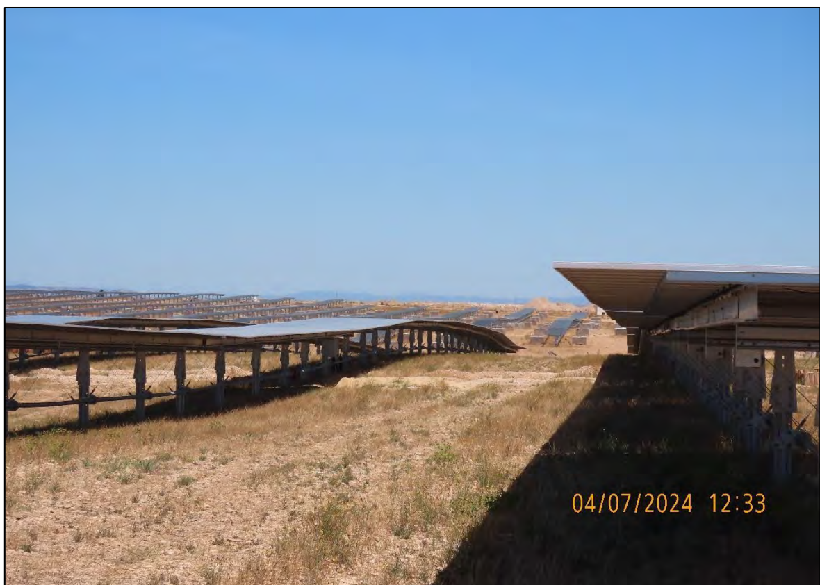
Ilustración 3. Instalación de paneles solares.
