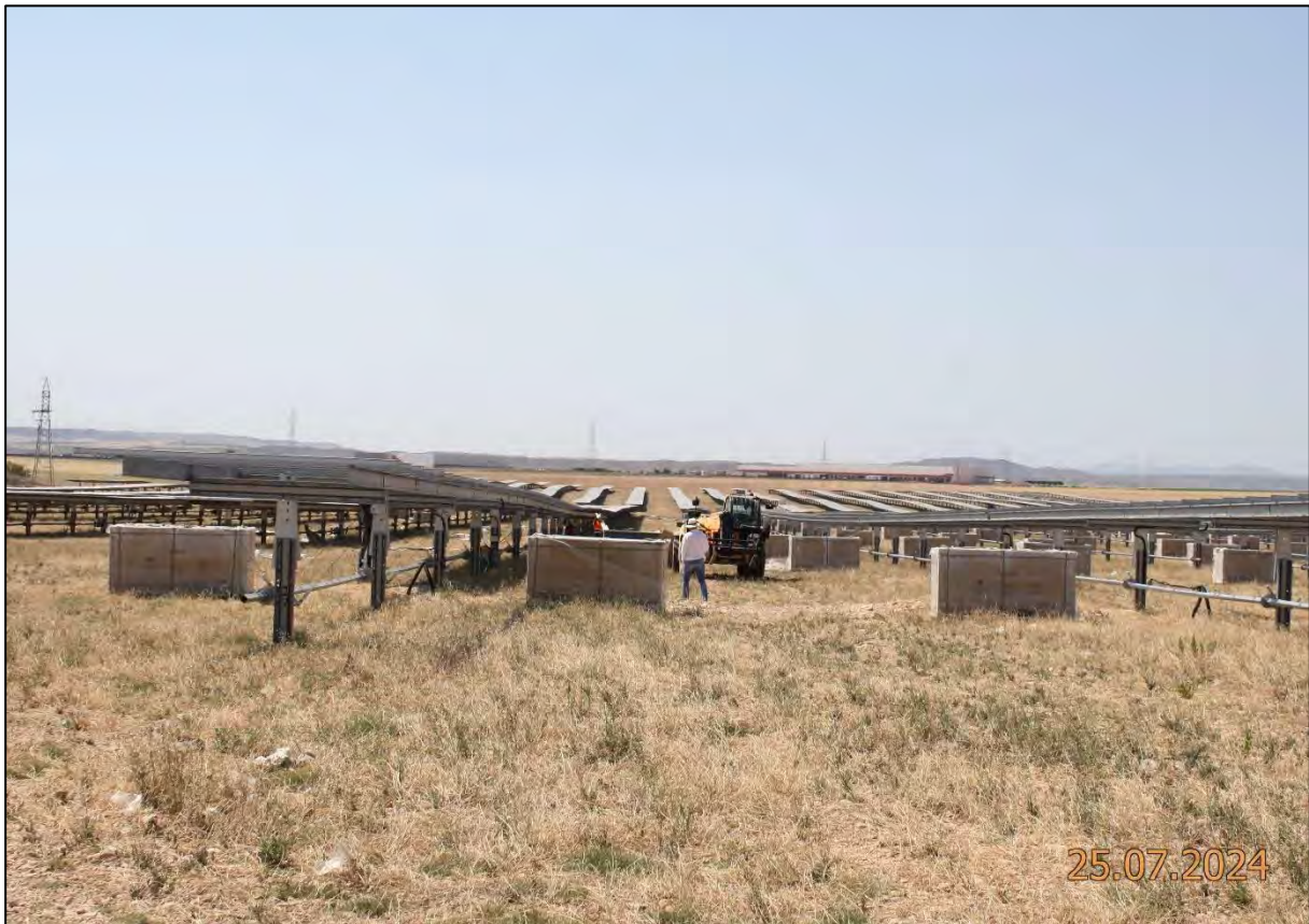
Ilustración 1. Instalación de paneles solares.
