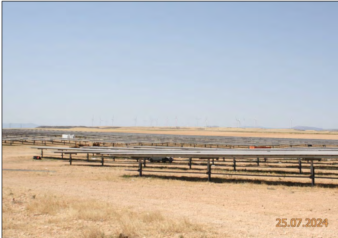
Ilustración 6. Estado actual del parque.
