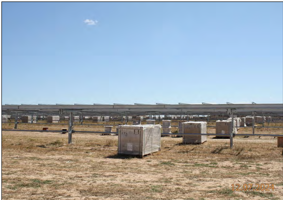
Ilustración 2. Instalación de paneles solares.
