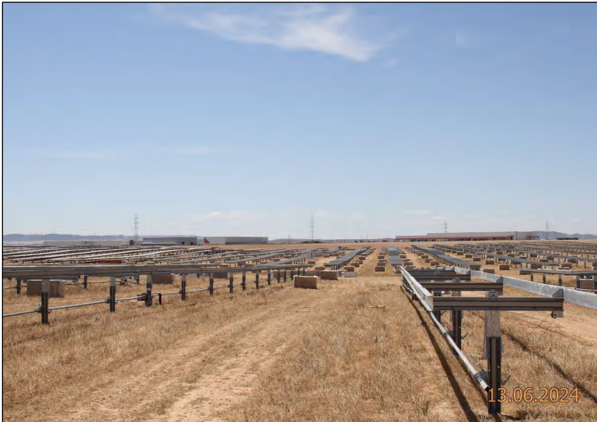
Ilustración 1. Finalización y repaso del montaje de las estructuras de los seguidores.
