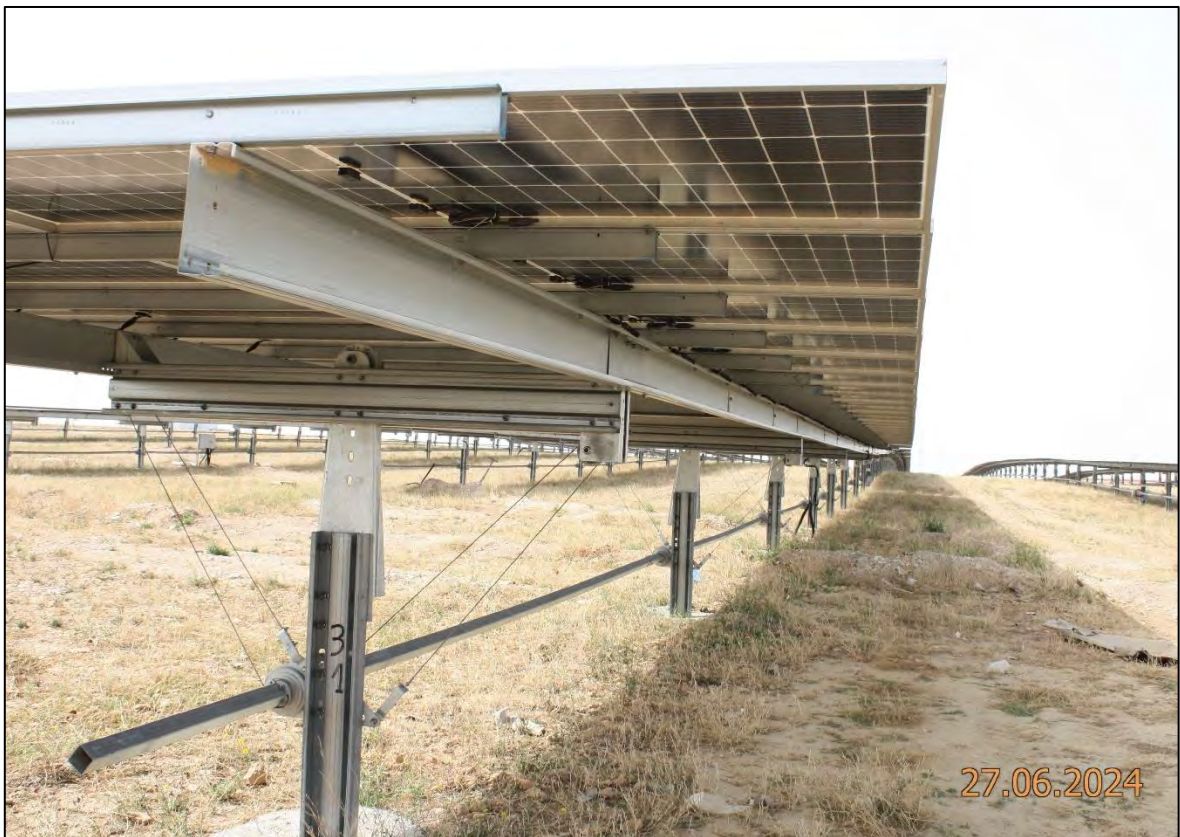
Ilustración 3. Instalación de paneles solares.
