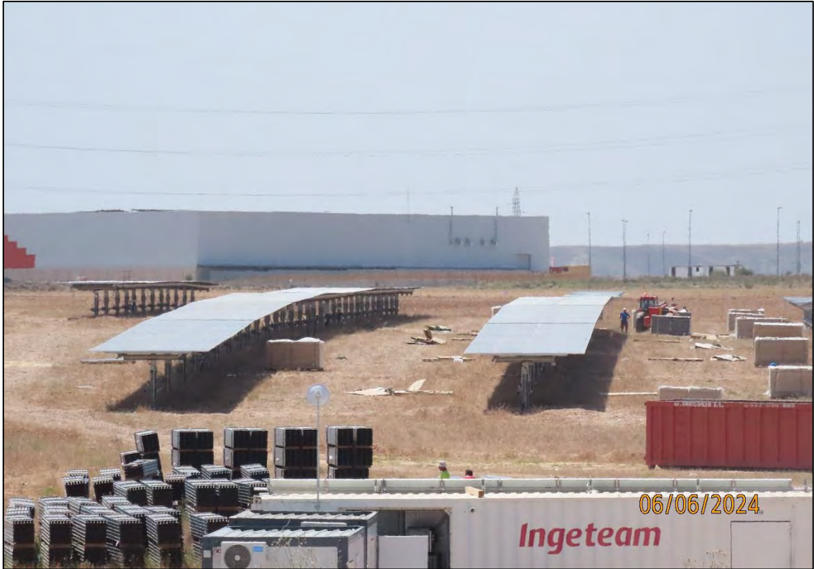
Ilustración 2. Inicio de la instalación de paneles solares.
