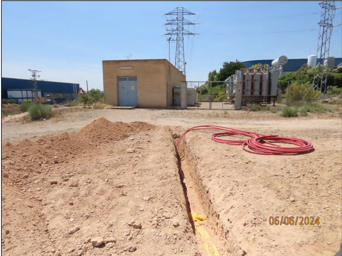
Ilustración 4. Trabajos en las zanjas de las líneas de evacuación.
