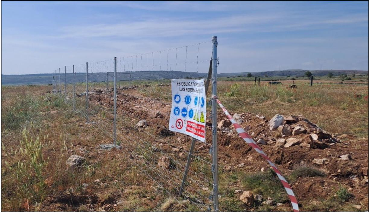
**Figura 5.** Instalación del vallado perimetral.
