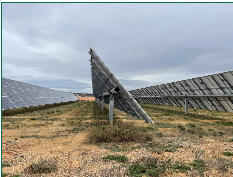
Fotografía 1. Vegetación entre placas actualmente.
