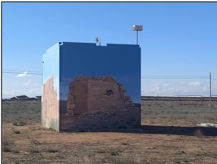
Fotografía 6. Exterior del primillar, pintado.
