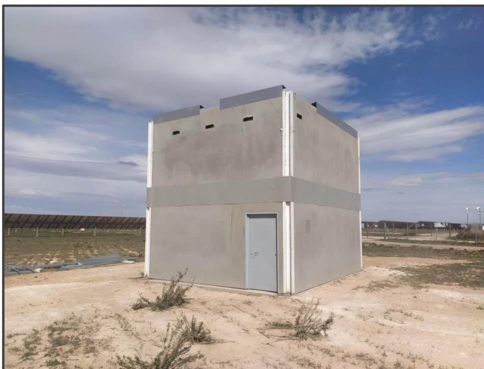
Fotografía 4. Exterior del primillar de nueva construcción.
