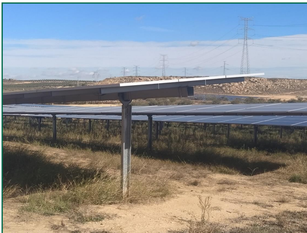
Fotografía 1. Vegetación entre placas actualmente.
