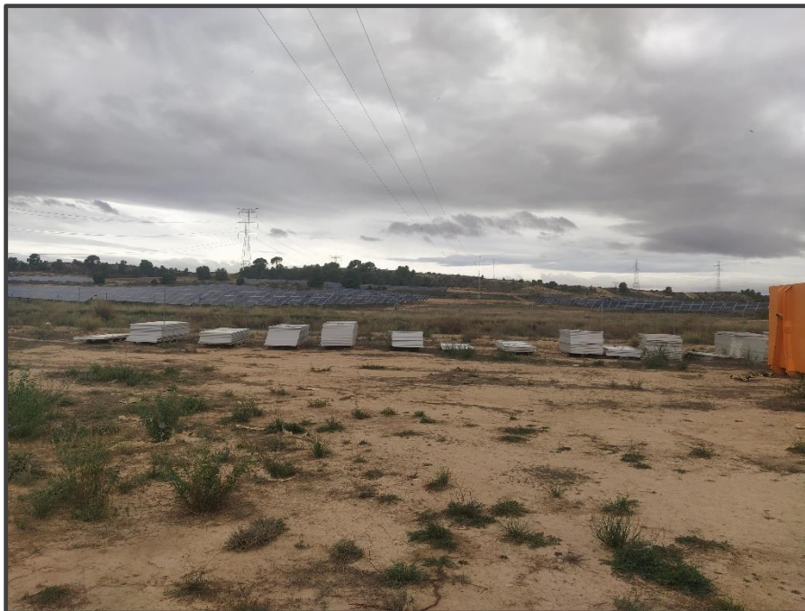
Fotografía 14. Zona de acopio de placas solares deterioradas.
