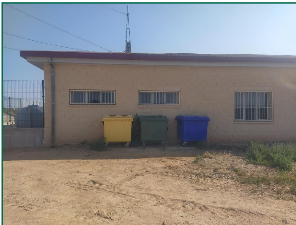
Fotografía 24. Contenedores de residuos no peligrosos en exterior de la subestación.
