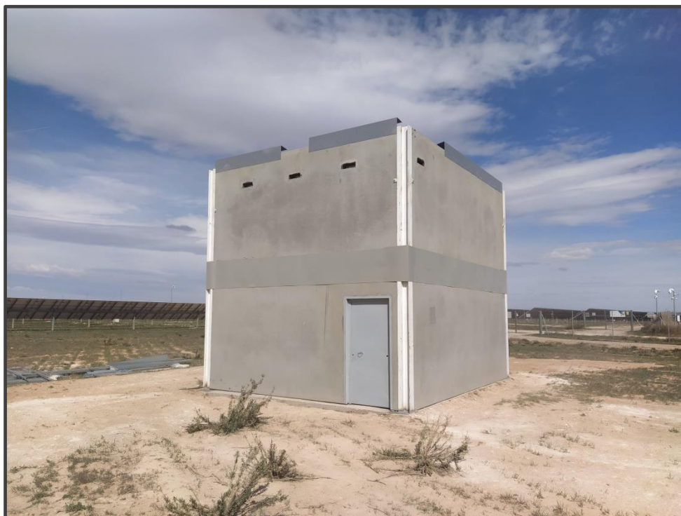
Fotografía 14. Exterior del primillar de nueva construcción.
