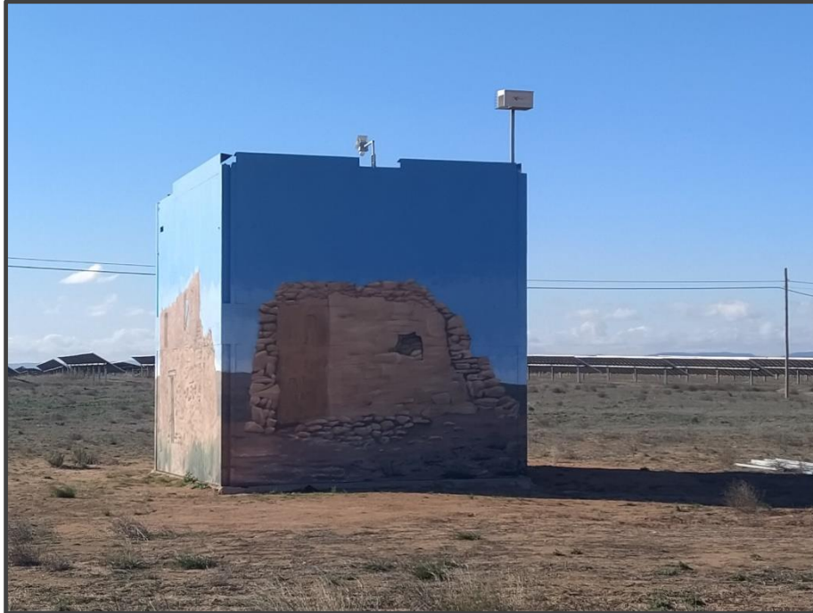
Fotografía 16. Exterior del primillar, pintado.
