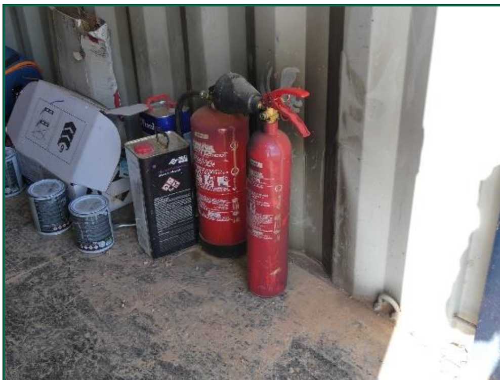
Fotografía 12. Material de extinción.
