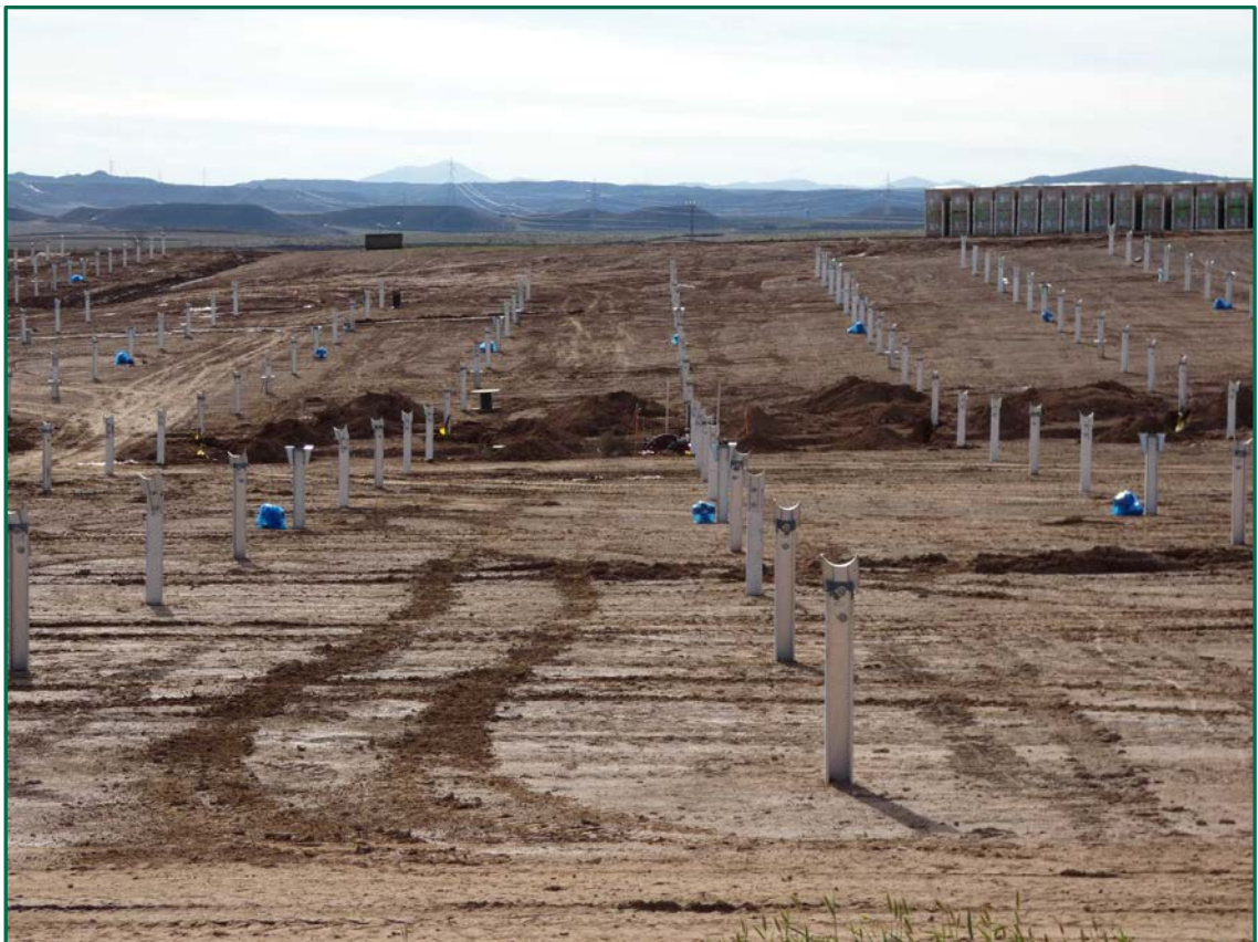
Fotografía 3. Superficie de la planta y colocación de postes para las placas fotovoltaicas.
