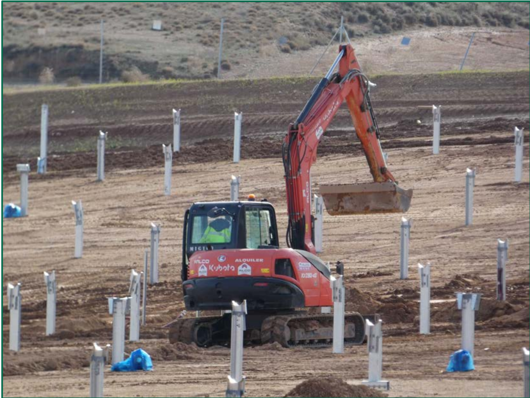
Fotografía 4. Maquinaria tapando zanjas.
