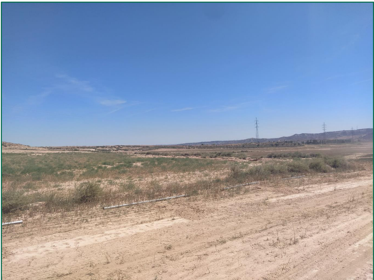
Fotografía 1. Proceso de colocación del vallado.
