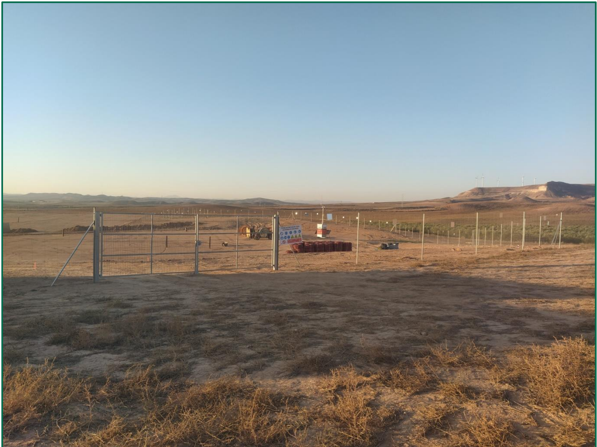
Fotografía 2. Vallado perimetral ya instalado.
