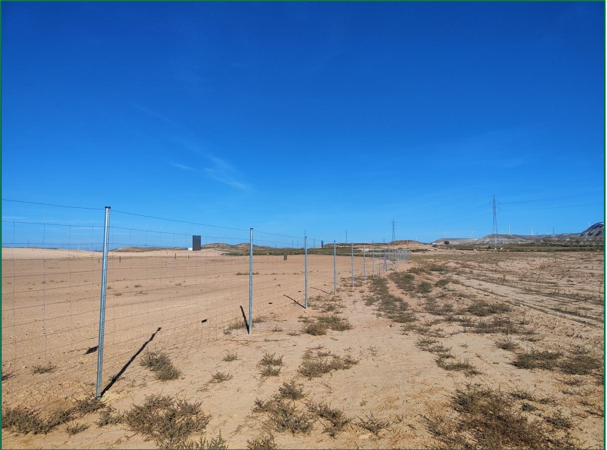
Fotografía 2. Vallado perimetral ya instalado.
