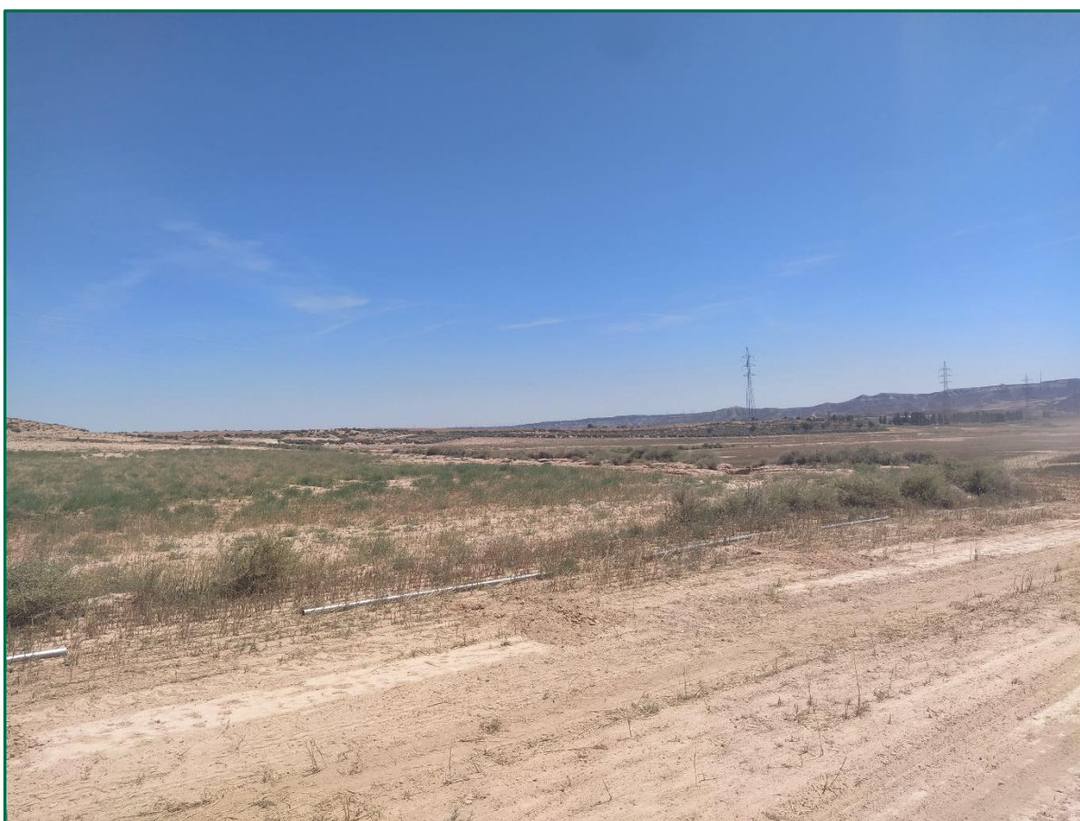
Fotografía 1. Proceso de colocación del vallado.
