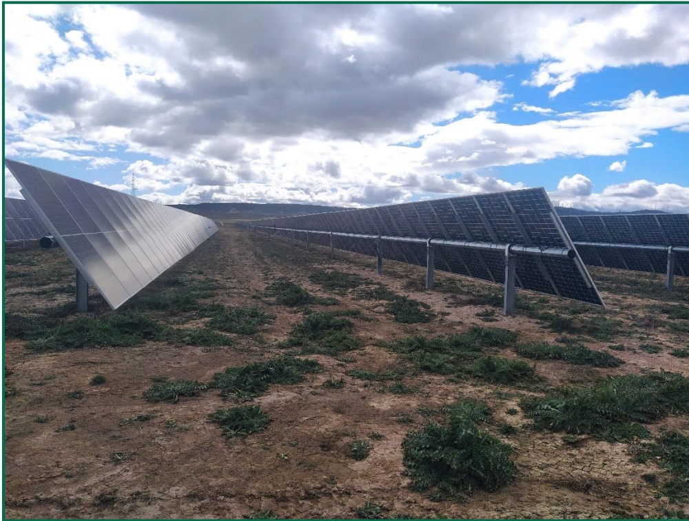
Fotografía 4. Hincas sobre el terreno.
