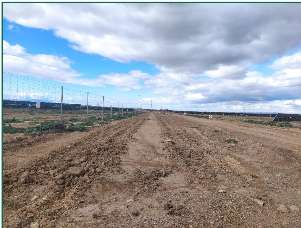
Fotografía 16. Zona con plantones ya colocados.
