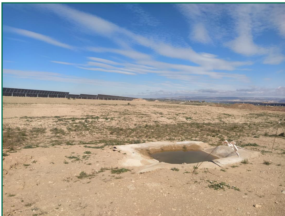
Fotografía 8. Basete ya construido.
