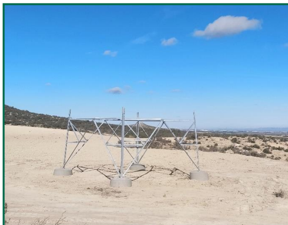
Fotografías 12, 13, 14 y 15. Apoyos en proceso de instalación.
