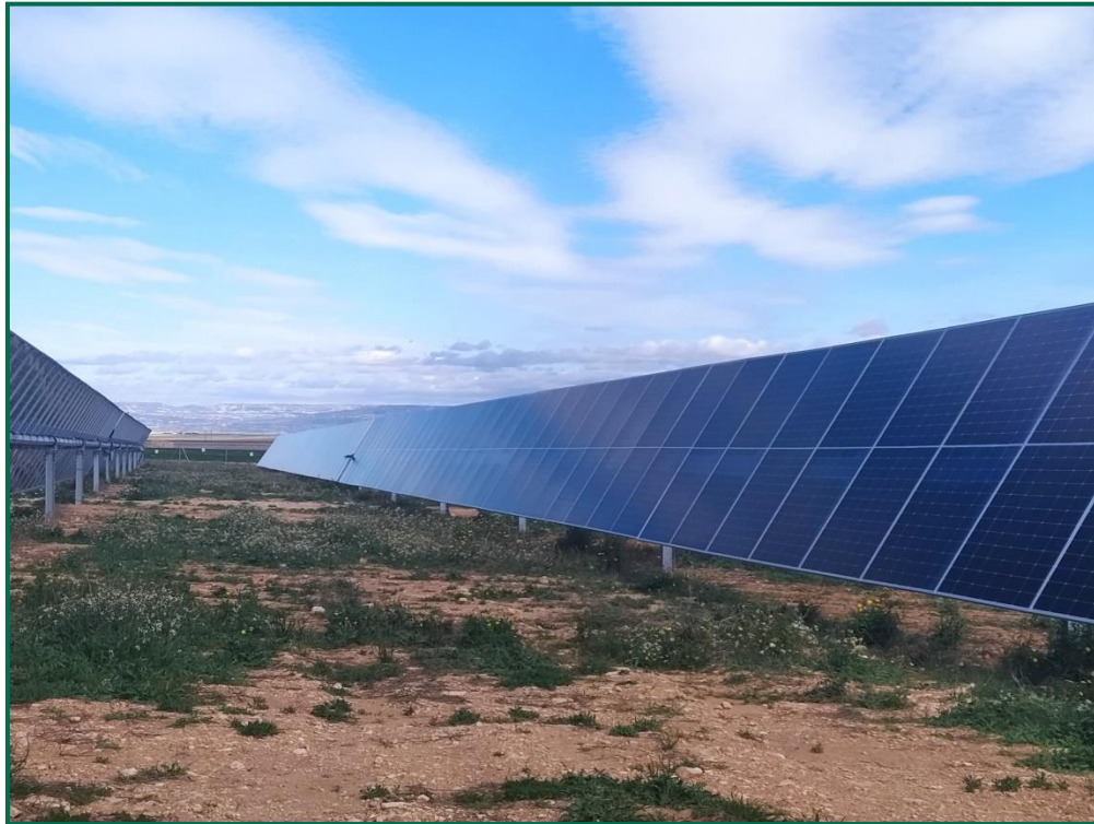
Fotografía 4. Hincas sobre el terreno.
