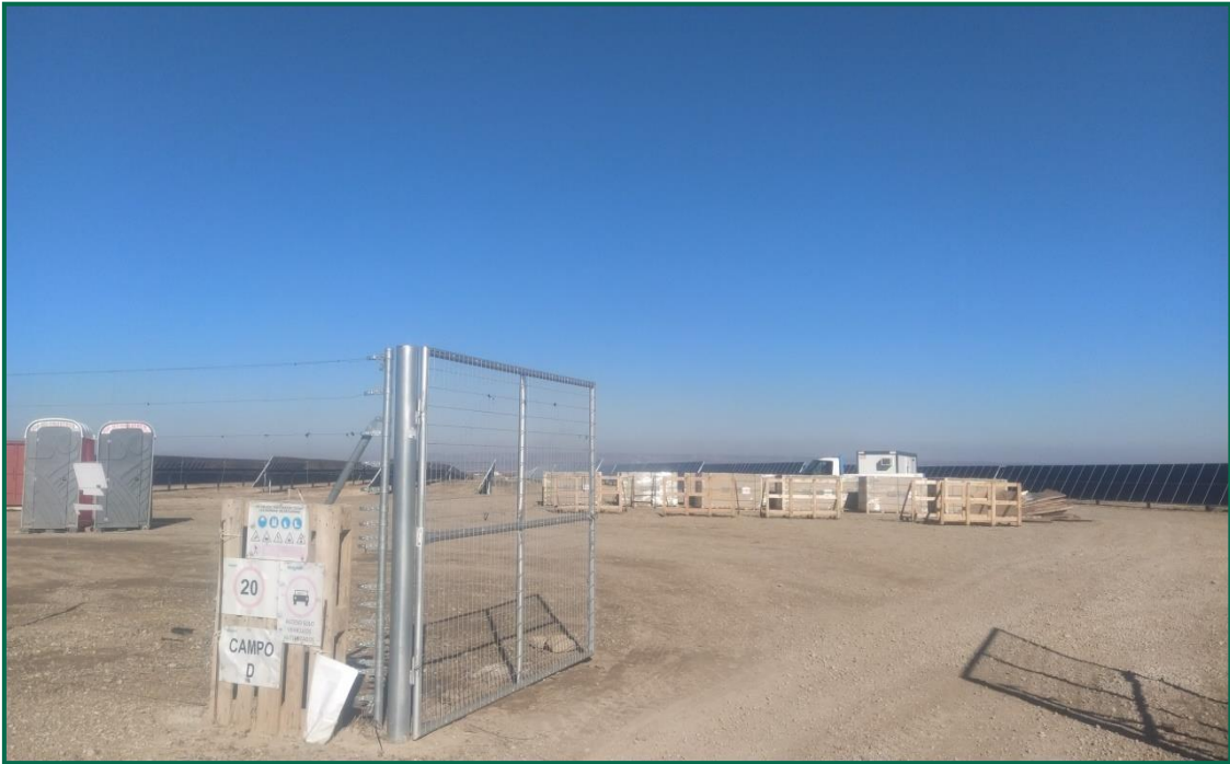
Fotografía 3. Señal de limitación de velocidad.
