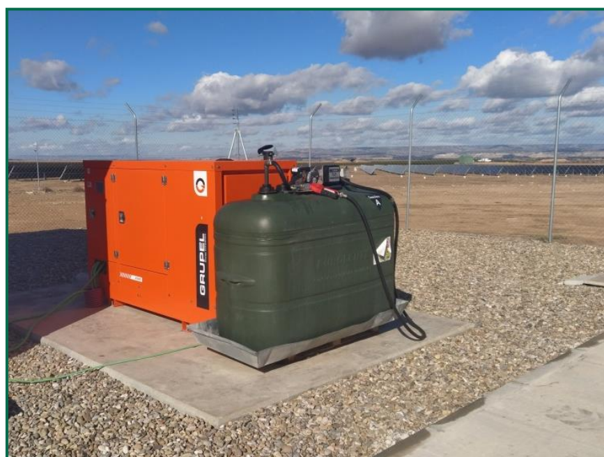
Fotografía 9. Grupo electrógeno.
