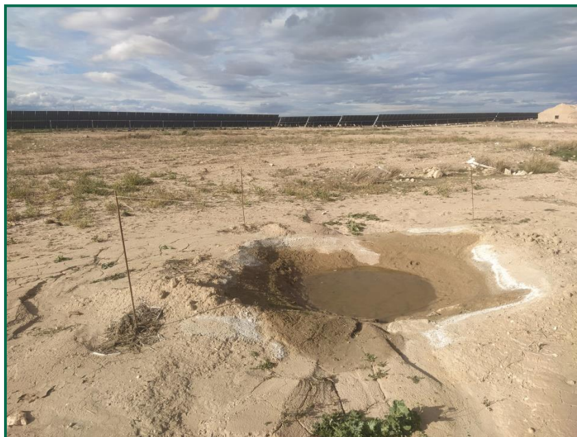
Fotografía 6. Balsete ya construido.
