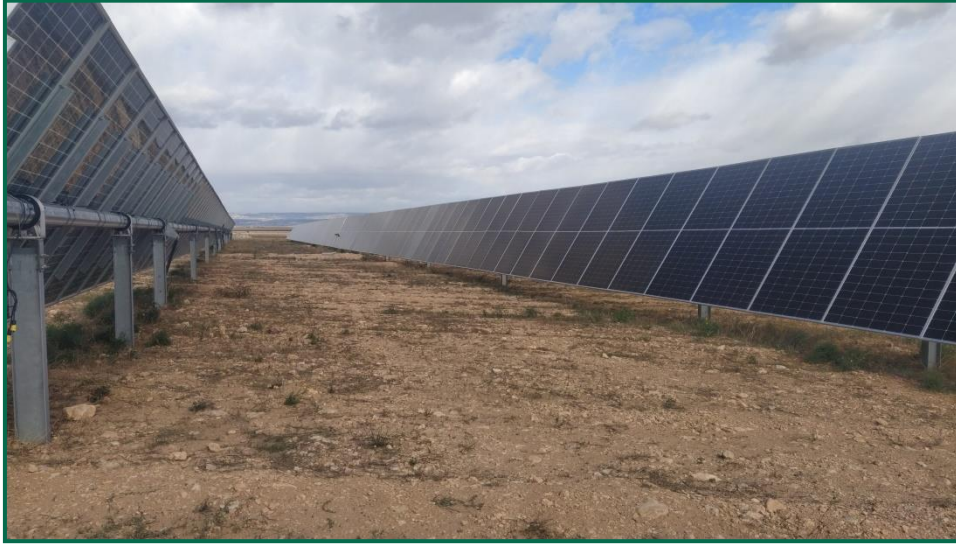
Fotografía 4. Hincas sobre el terreno.
