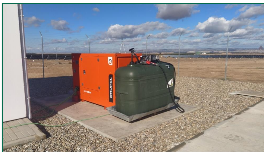
Fotografía 9. Grupo electrógeno.
