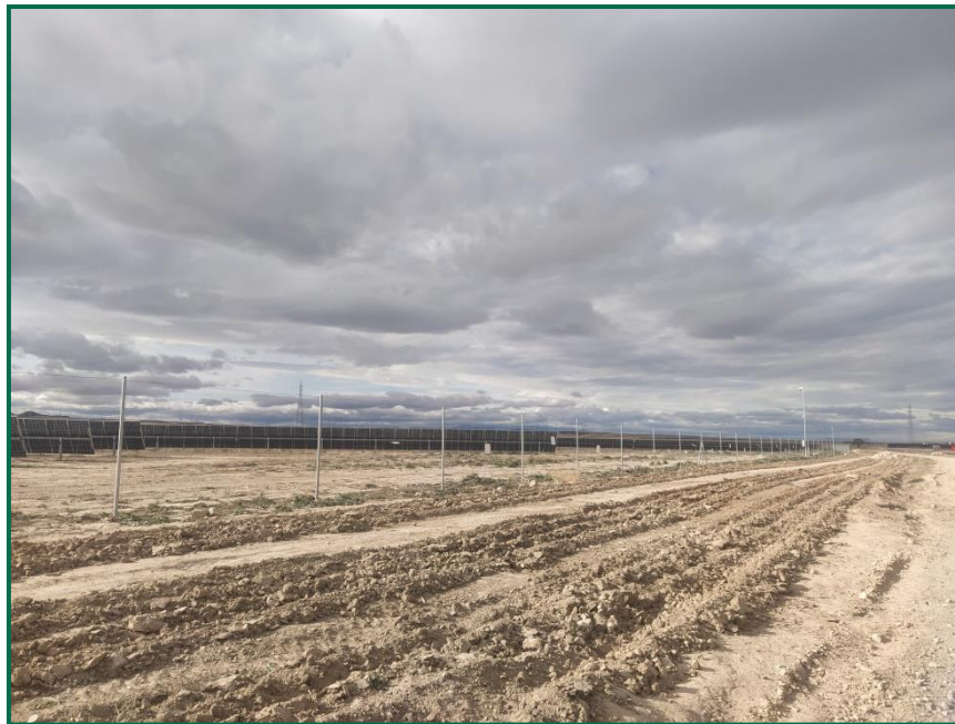
Fotografía 10. Preparación del terreno para plantaciones.
