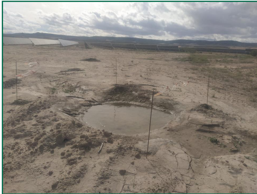
Fotografía 7. Basete ya construido.
