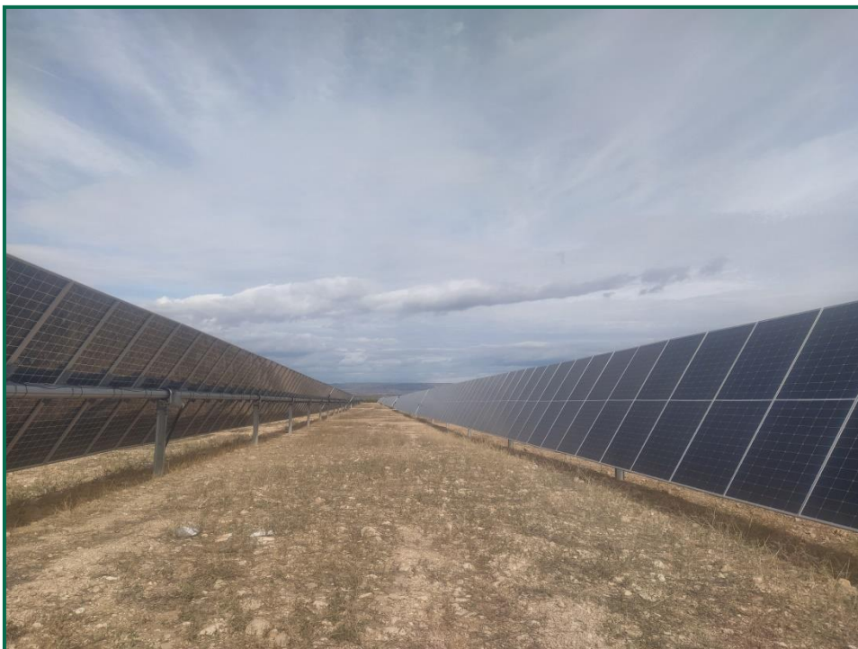
Fotografía 5. Hincas sobre el terreno.
