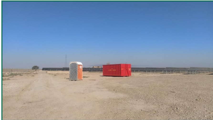
Fotografía 10. Contenedores para voluminosos.
