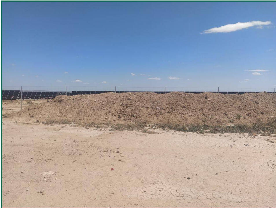
Fotografía 4. Acopio de tierra.
