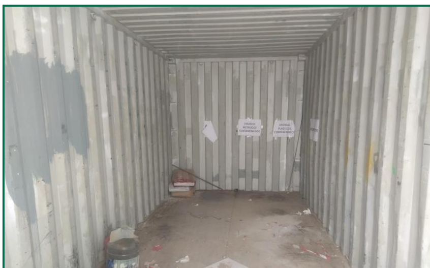
Fotografía 9. Bidones para residuos peligrosos.
