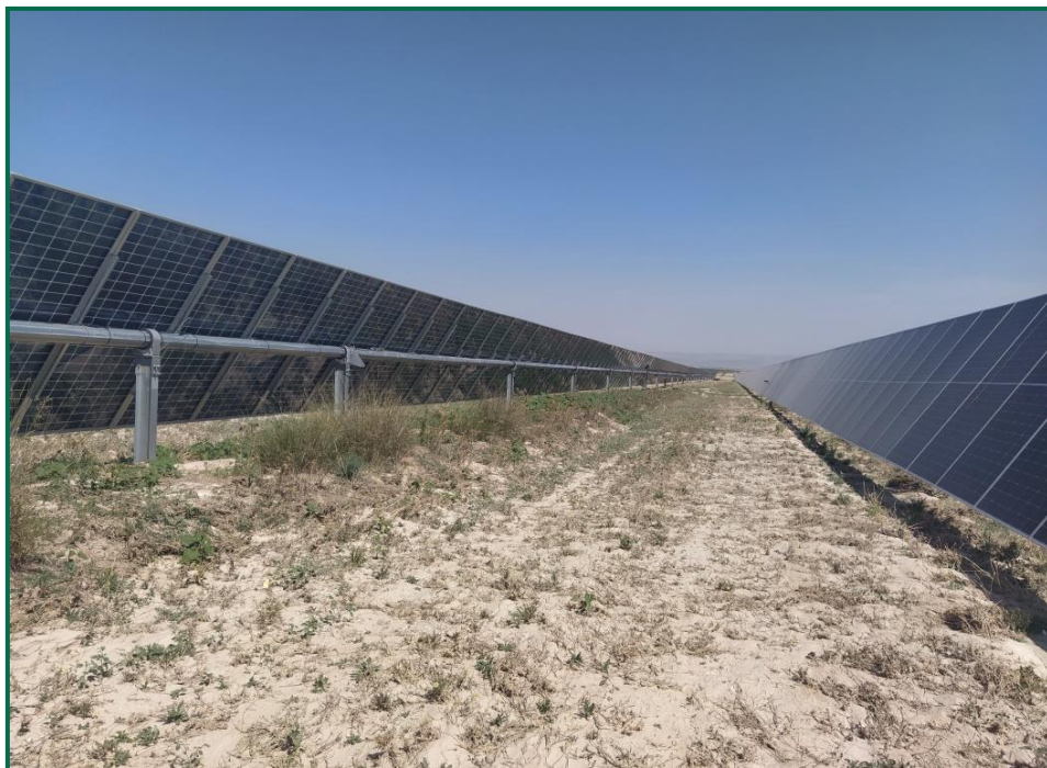
Fotografía 5. Hincas sobre el terreno.
