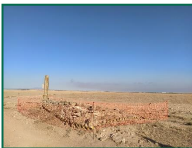
Fotografía 17. Muelle de carga
