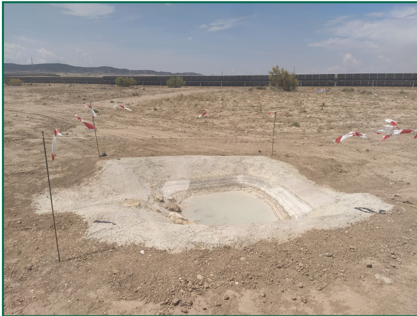
Fotografía 8. Basete ya construido.
