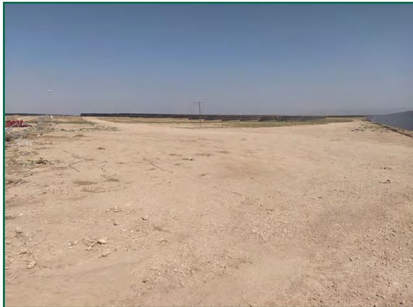
Fotografía 11. Zona de lavado de hormigón, ya eliminada.
