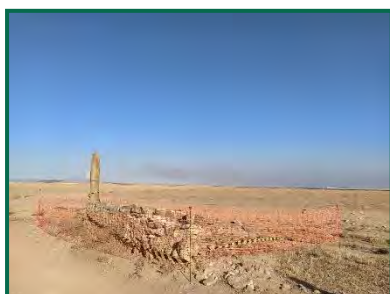
Fotografía 19. Muelle de carga
