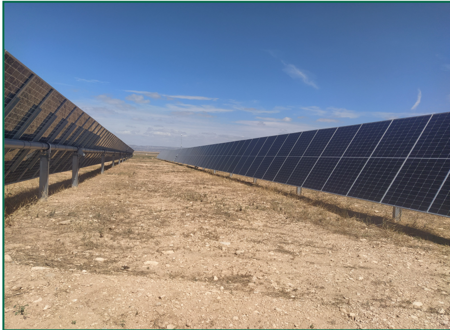
Fotografía 6. Hincas sobre el terreno.
