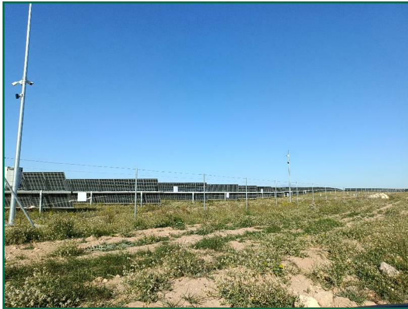
Fotografía 9. Zona con plantones ya colocados.
