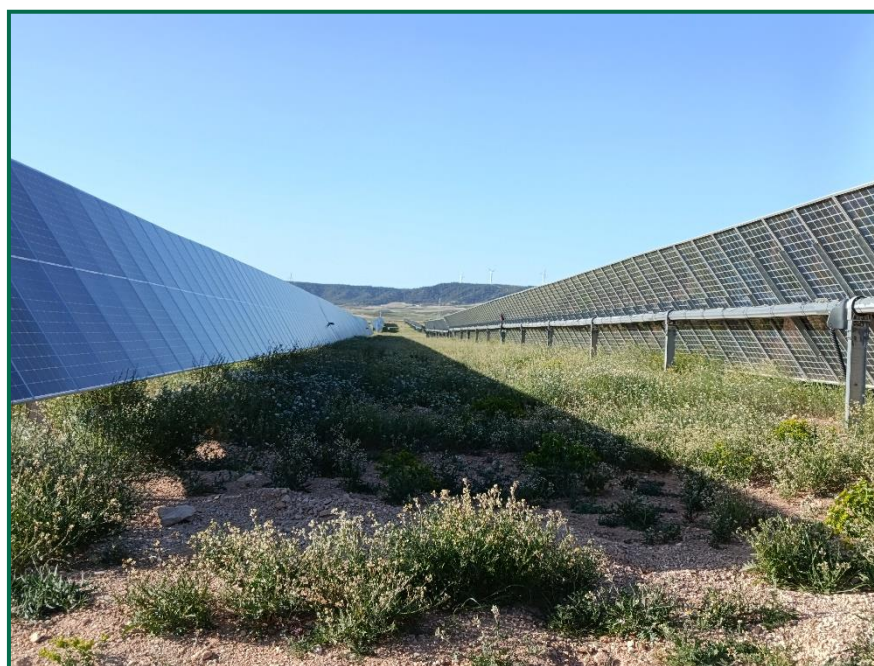
Fotografía 4. Hincas sobre el terreno.
