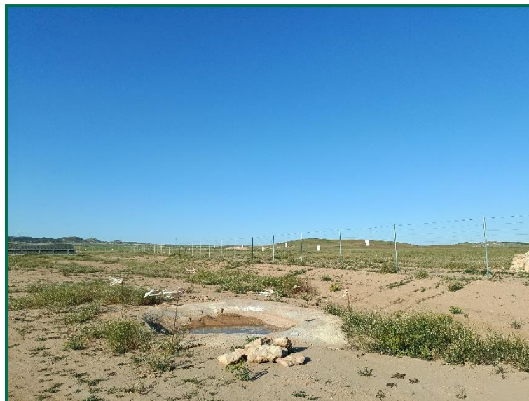
Fotografía 6. Balsa ya construido.
