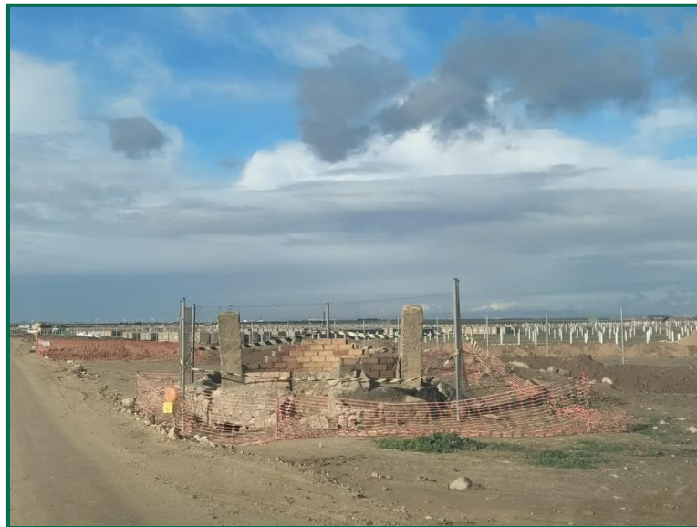
Fotografía 12. Muelle de carga
