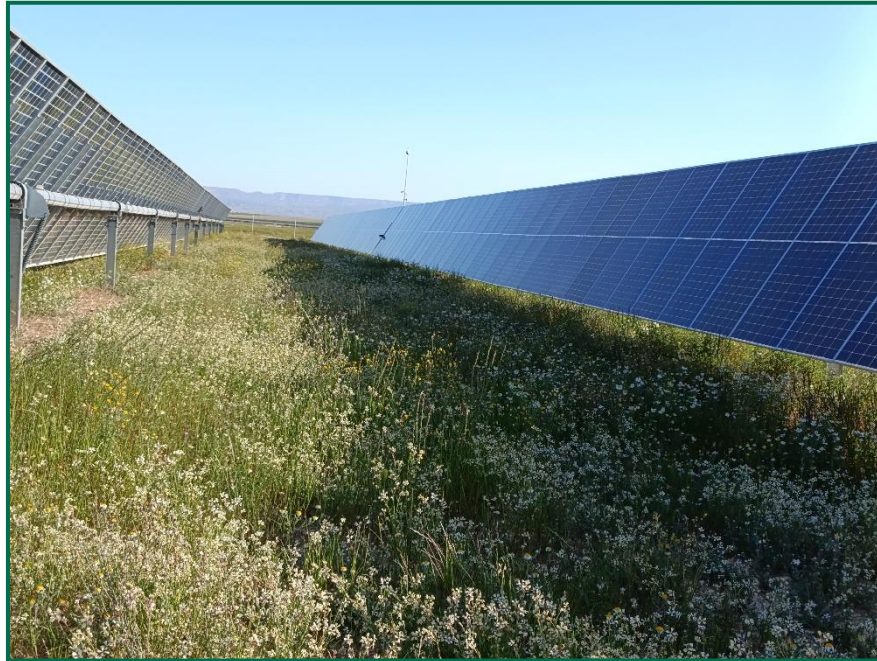
Fotografía 4. Hincas sobre el terreno.
