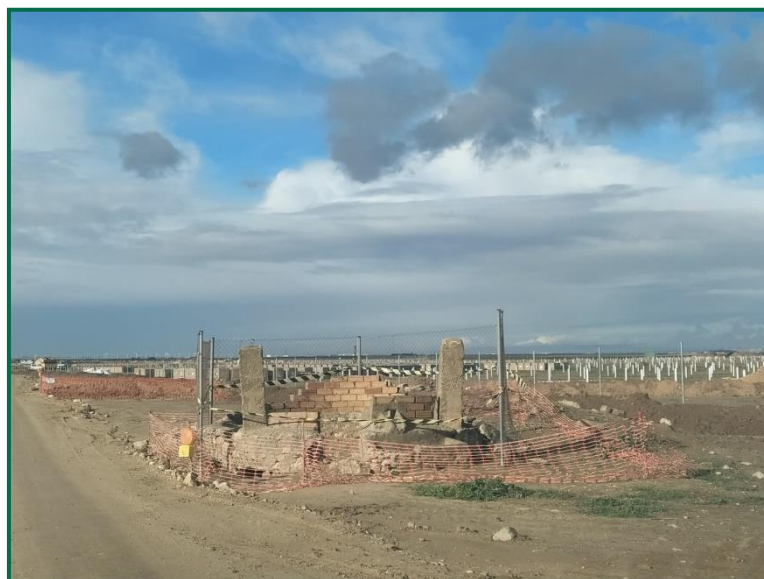
Fotografía 14. Muelle de carga
