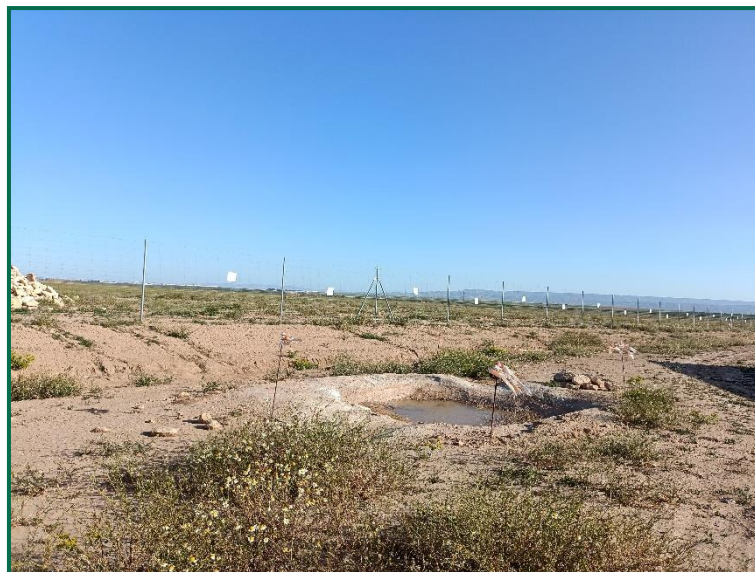
Fotografía 6. Balsa ya construido.
