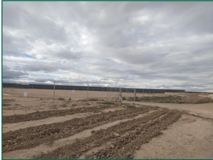
Fotografía 10. Preparación del terreno para plantaciones.
