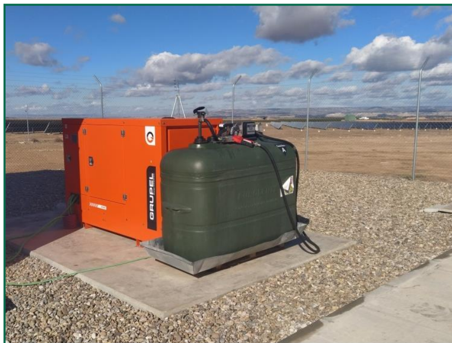
Fotografía 9. Grupo electrógeno.
