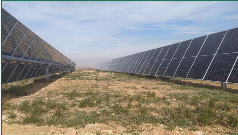
Fotografía 4. Hincas sobre el terreno.
