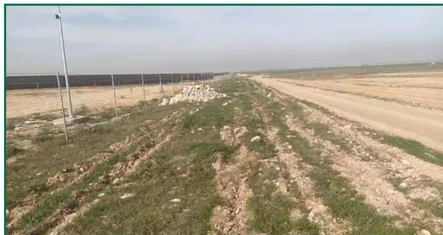
Fotografía 11. Zona con plantones ya colocados.
