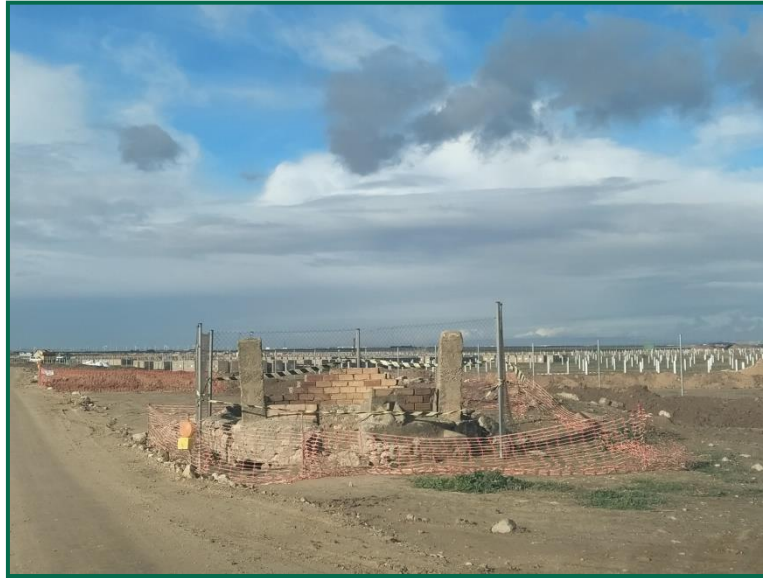
Fotografía 15. Muelle de carga
