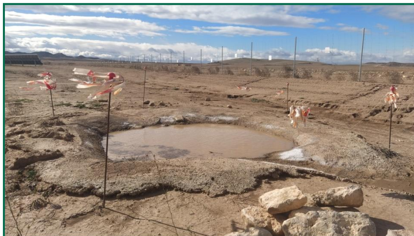
Fotografía 6. Balsa ya construido.
