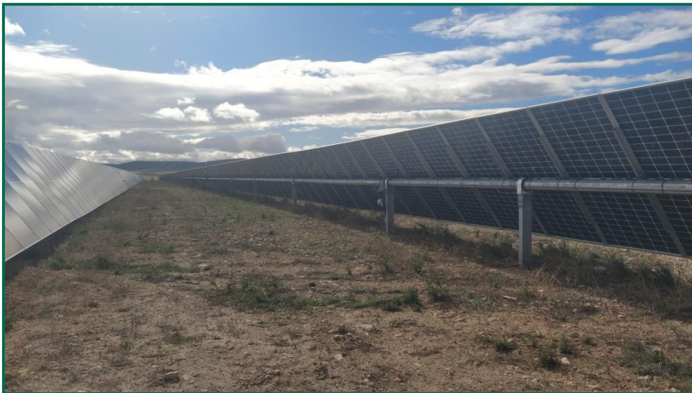
Fotografía 4. Hincas sobre el terreno.
