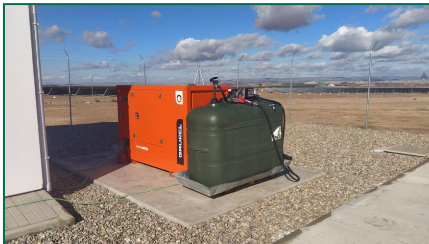
Fotografía 9. Grupo electrógeno.
