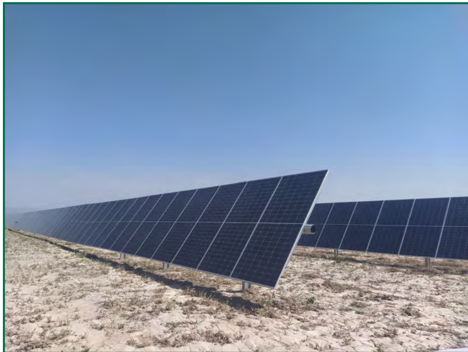
Fotografía 5. Hincas sobre el terreno.
