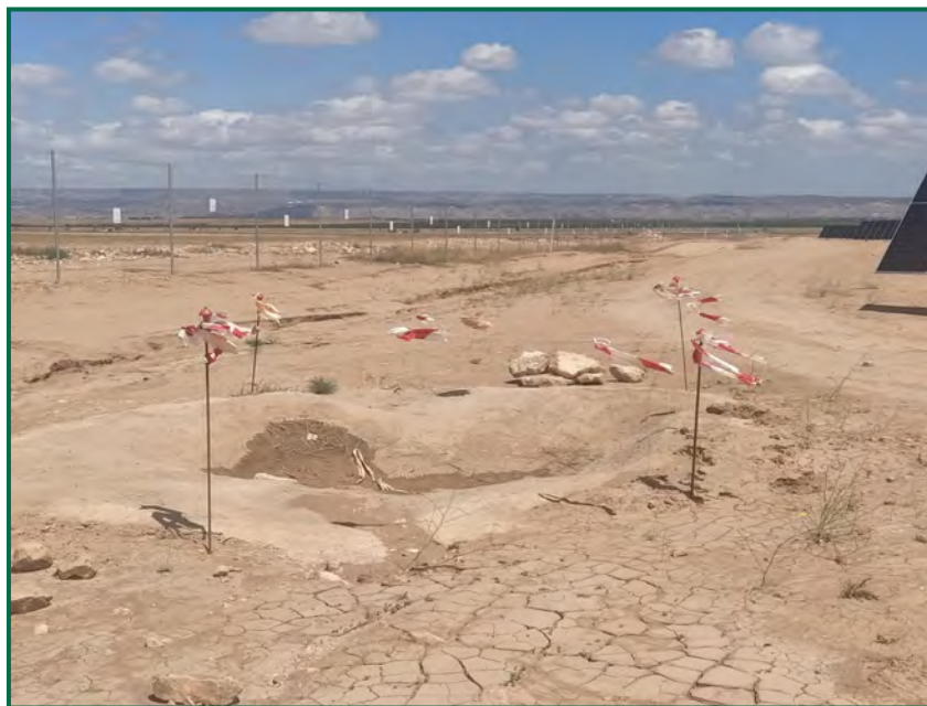
Fotografía 7. Basete ya construido.
