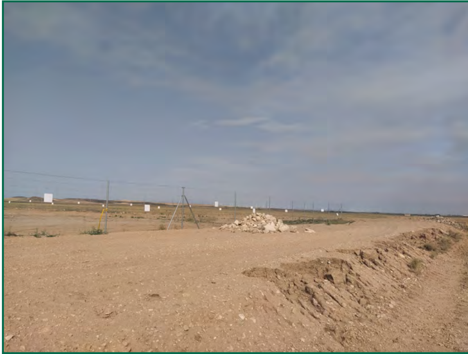
Fotografía 4. Acopio de tierra ya extendida.
