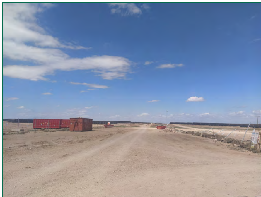
Fotografía 11. Contenedores para voluminosos.
