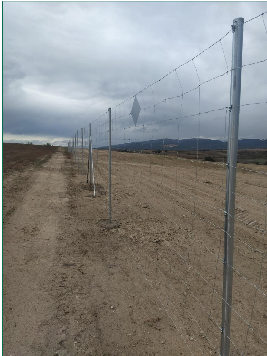
Fotografía 3. Vallado ya instalado por completo.
