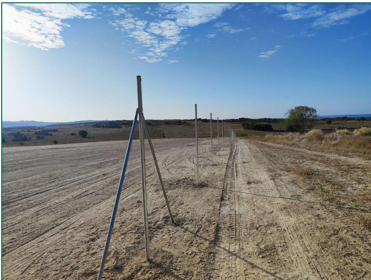
Fotografía 1. Proceso de colocación del vallado.
