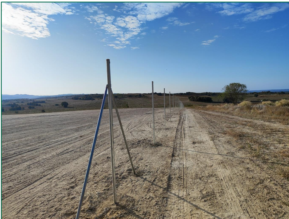
Fotografía 2. Proceso de colocación del vallado.
