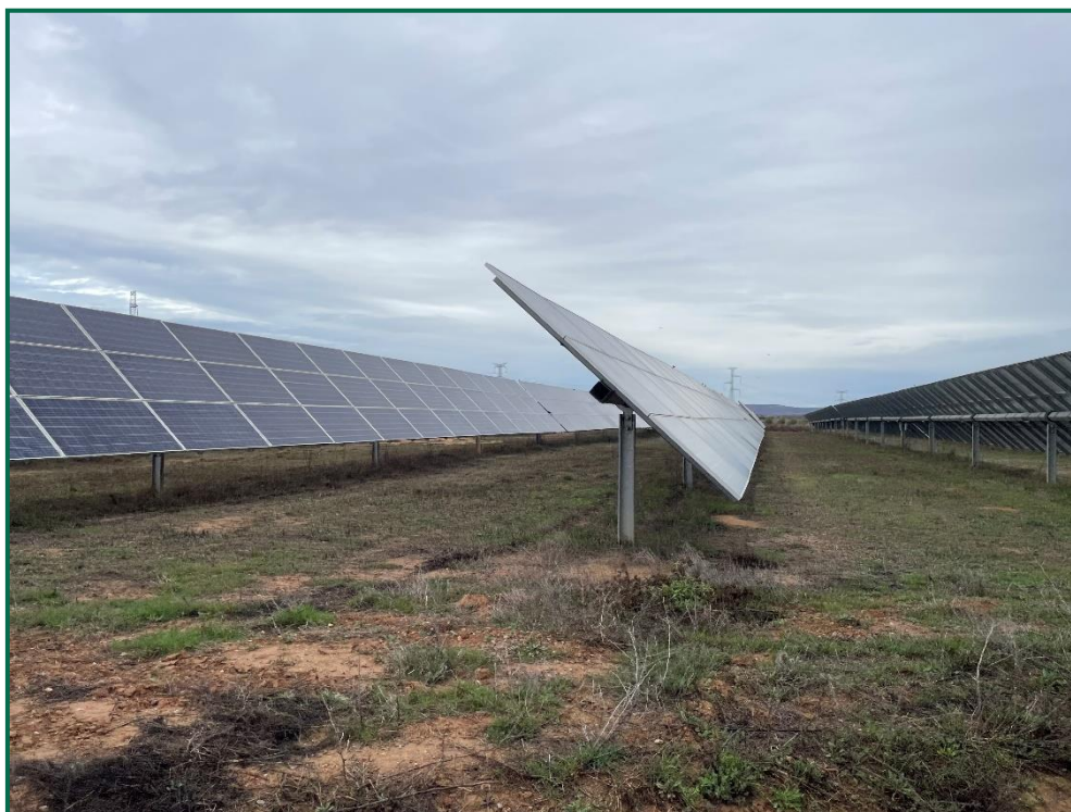
Fotografía 1. Vegetación entre placas actualmente.
