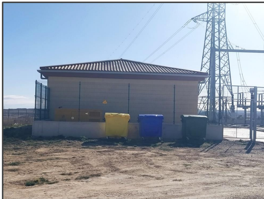
Fotografía 15. Contenedores de residuos junto a la subestación.
