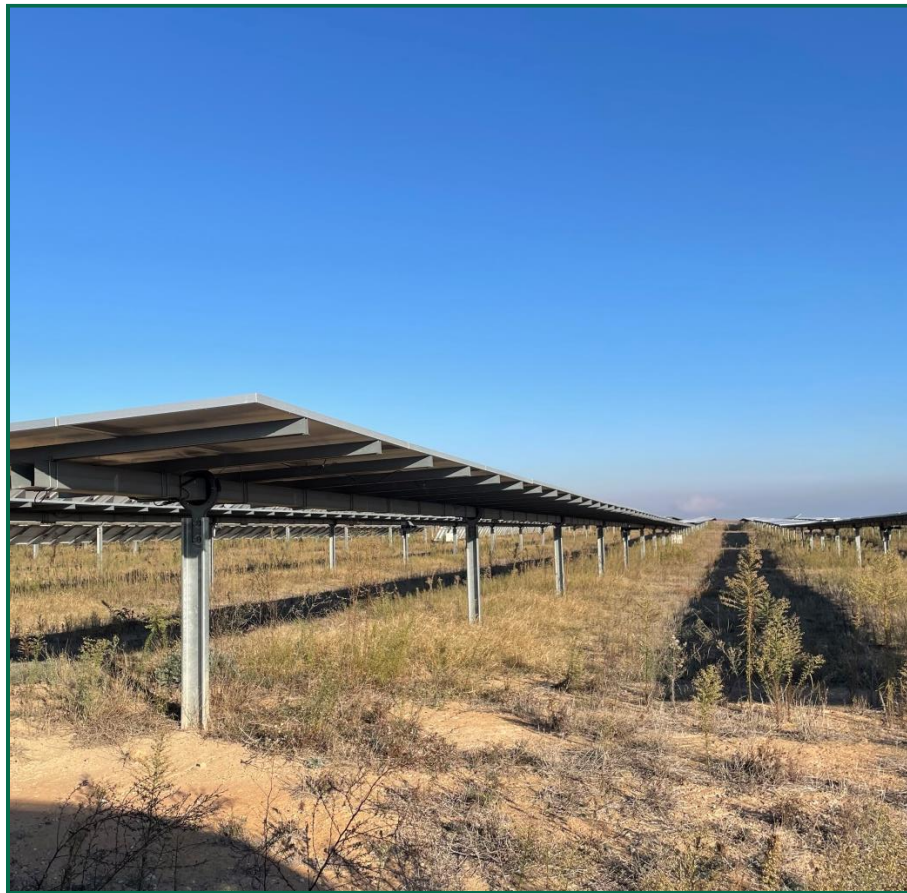
Fotografía 1. Vegetación entre placas en su estado actual.
