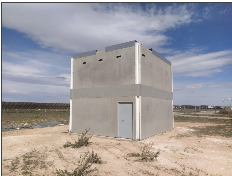
Fotografía 4. Exterior del primillar de nueva construcción.
