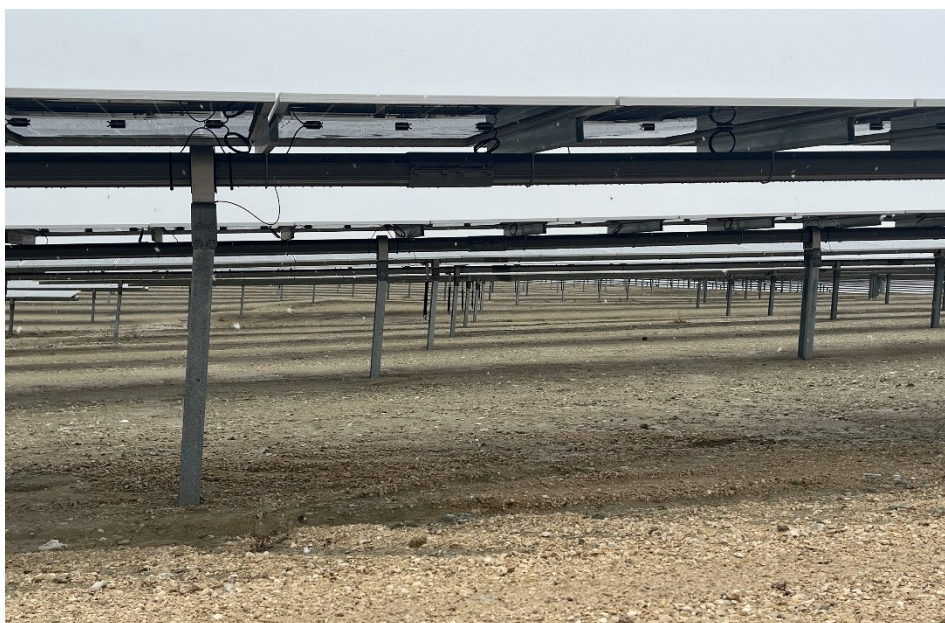
Figura 8 Estado de la vegetación bajo los módulos
